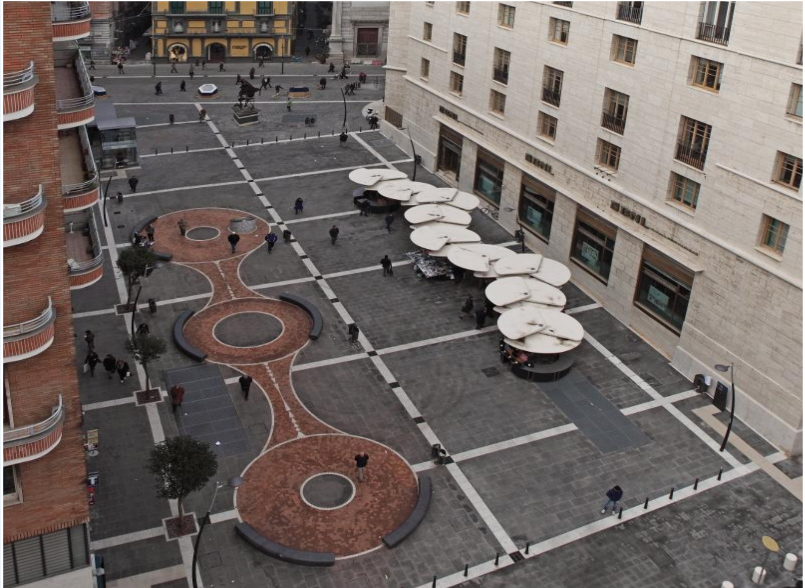
VIA DIAZ DOPO L'INTERVENTO
