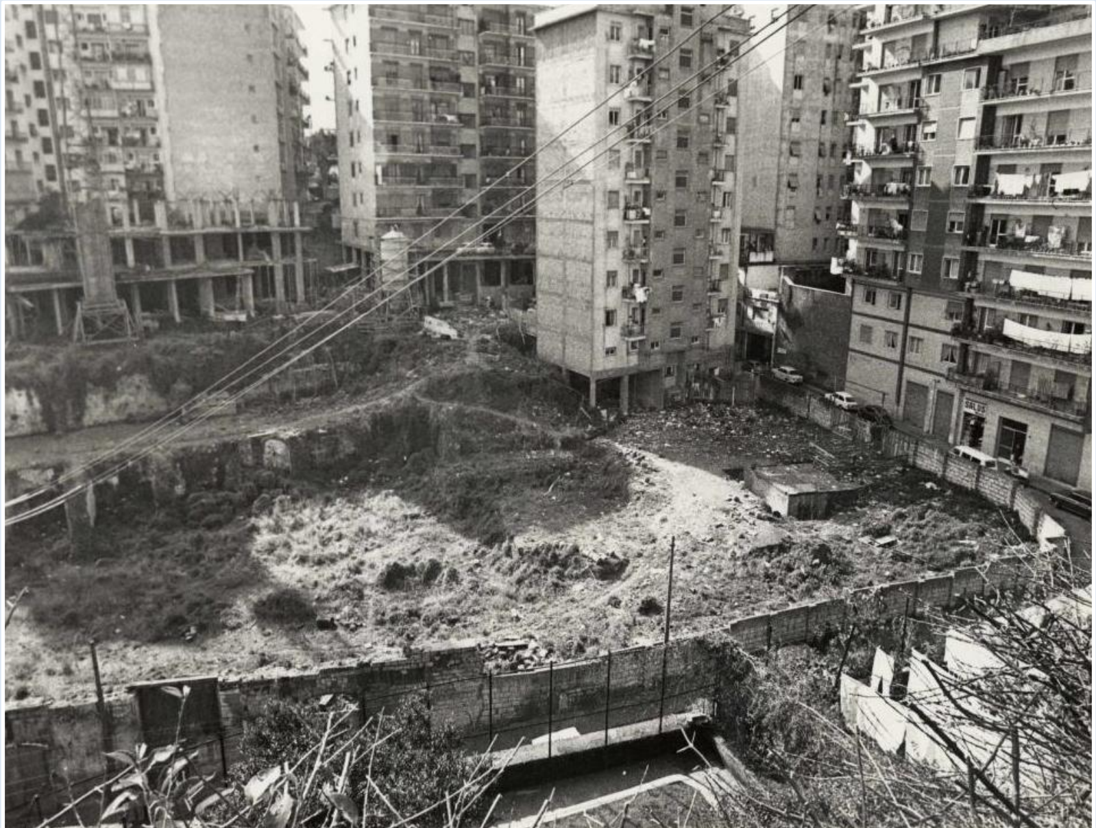
AREA PRIMA DELL'INTERVENTO (1969)
