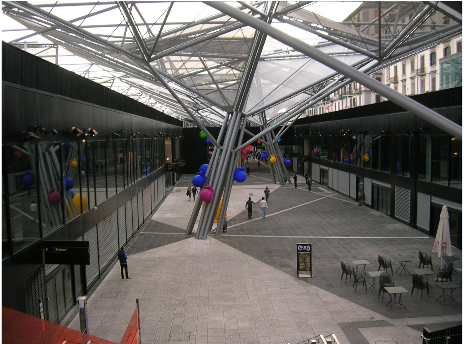
INGRESSO STAZIONE – TUNNEL COMMERCIALE
