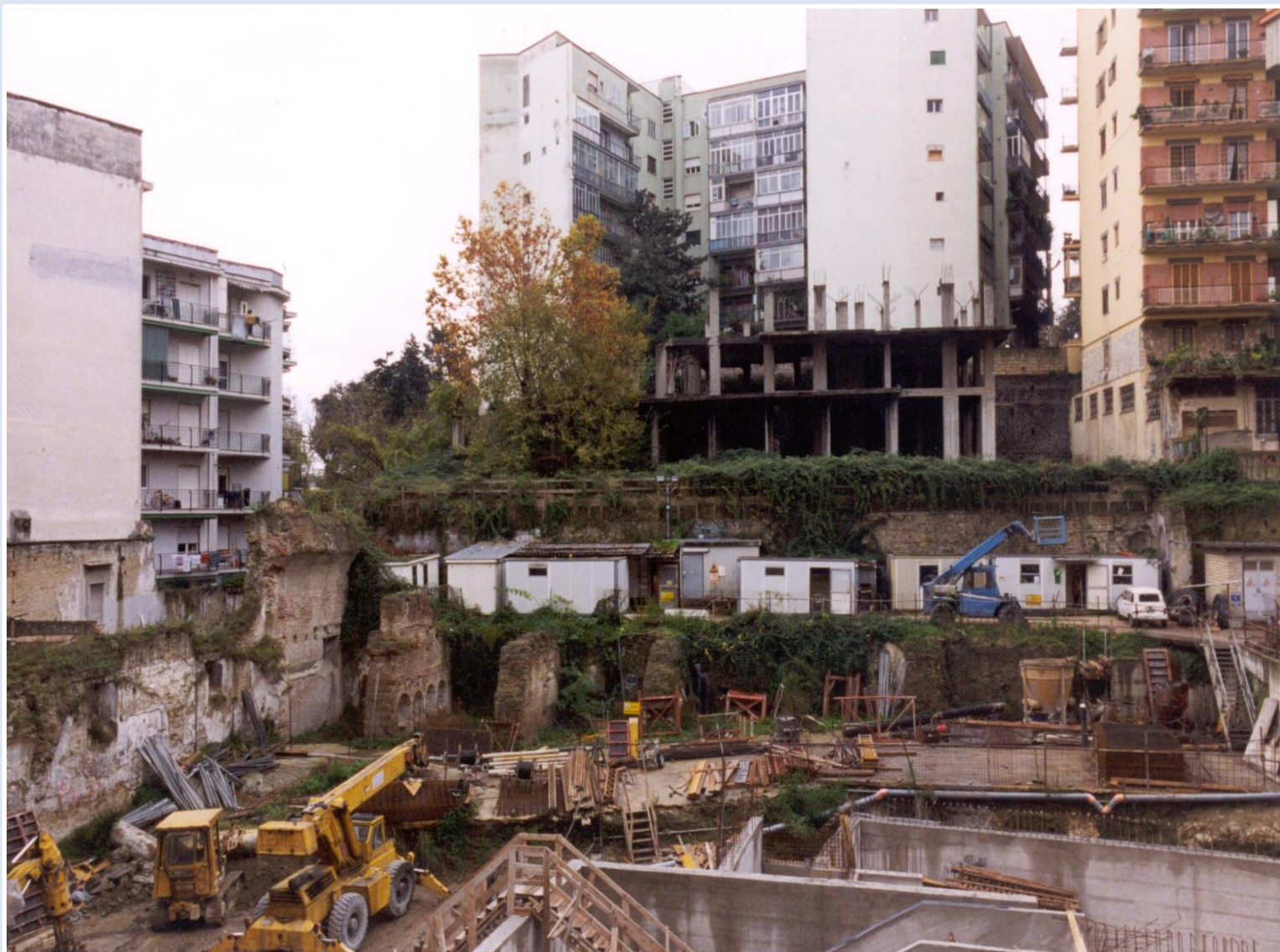
AREA DURANTE L'INTERVENTO (2000)
