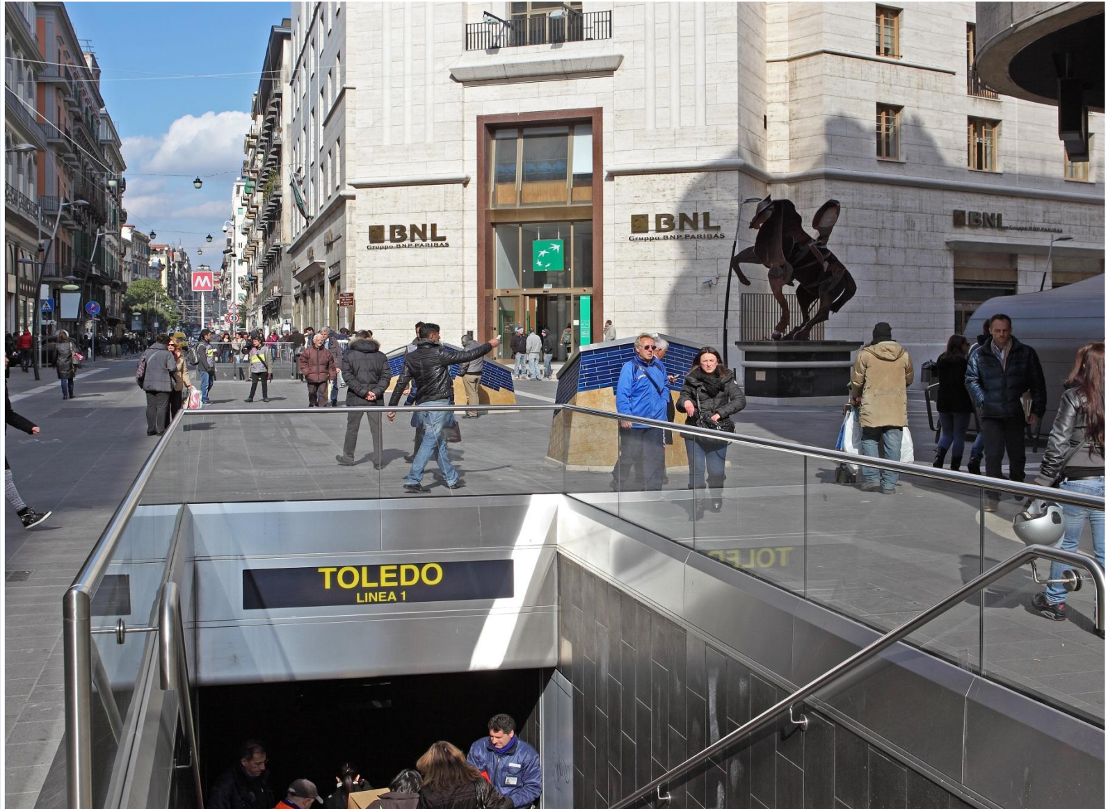
VIA DIAZ DOPO L'INTERVENTO
