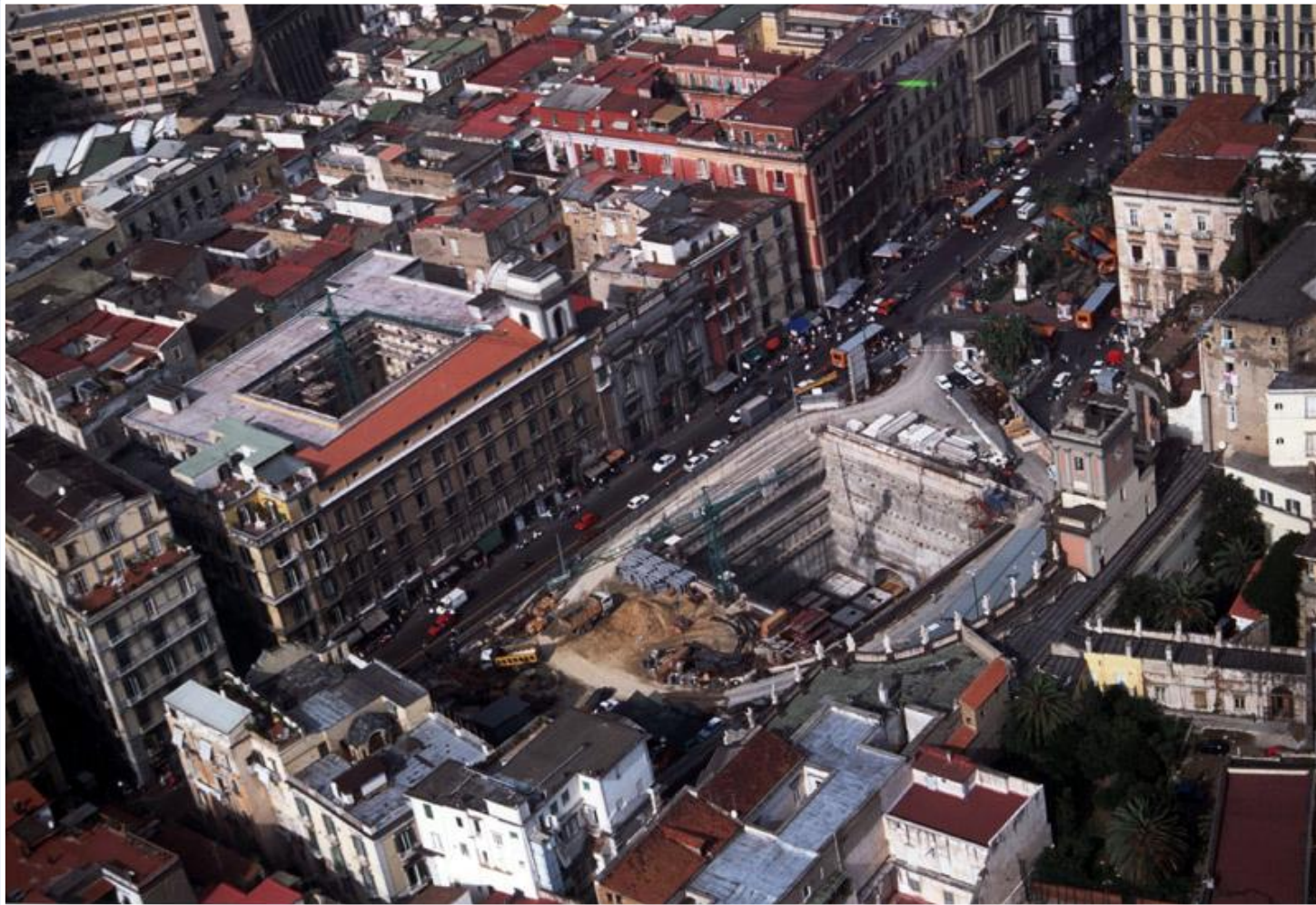
PIAZZA DANTE DURANTE L'INTERVENTO
