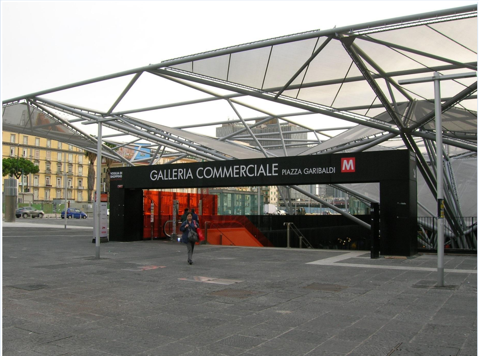
INGRESSO STAZIONE – TUNNEL COMMERCIALE
