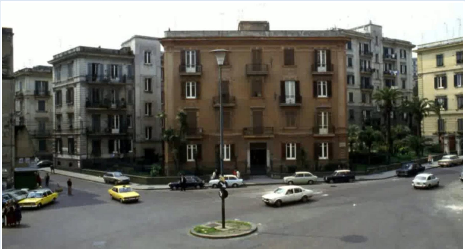
PIAZZA SCIPIONE AMMIRATO PRIMA DELL'INTERVENTO (1970)
