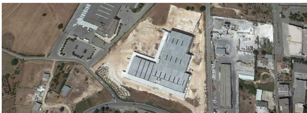
Figura 95 - Zona industriale di Martina Franca (TA) – completamento capannone industriale.
