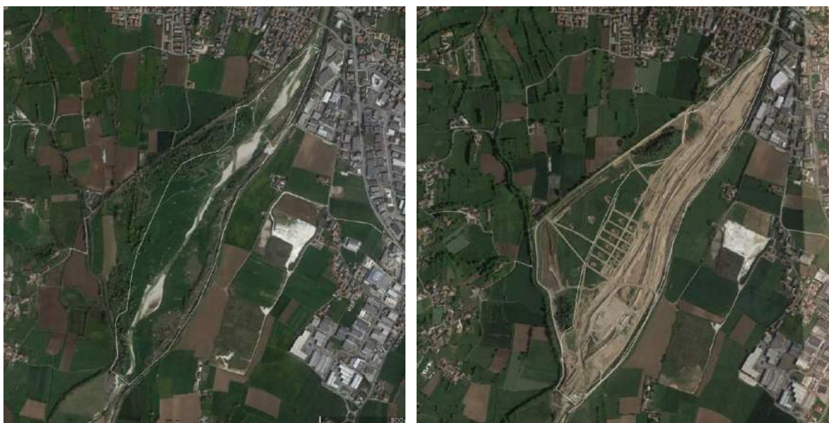
Figura 50 - Un bacino di laminazione del fiume Agno-Guà, con un invaso per 2,5 milioni di metri cubi ed esteso 49 ettari, è l'opera infrastrutturale per la mitigazione del rischio idrogeologico che ha spinto il Comune di Trissino (8.800 abitanti per un'area di 21 km 2 ), in provincia di Vicenza, al terzo posto dei comuni che nell'ultimo anno hanno maggiormente incrementato, rispetto al 2016, il loro consumo di suolo (51 ettari in totale).
