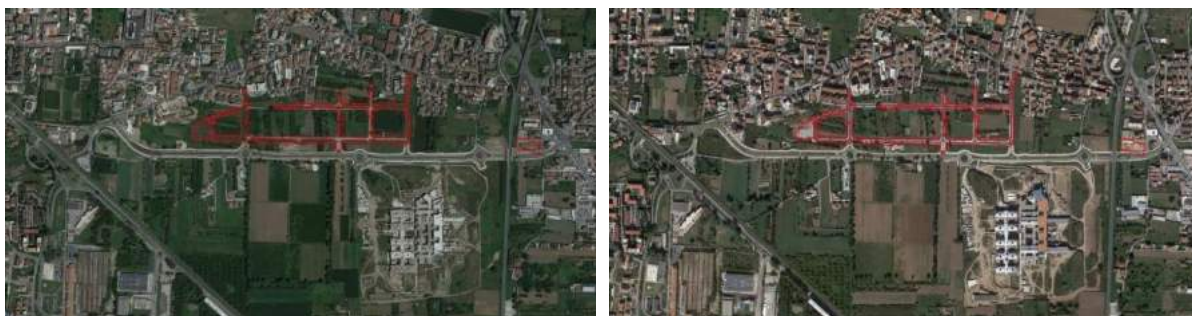
Figura 91 - L'incremento di consumo di suolo a Caserta (7,7 ettari) è dovuto principalmente alla realizzazione di una serie di strade nei pressi del nuovo Policlinico. Tale intervento, che si sviluppa nell'ambito urbano ad est della città, ha lo scopo principale di creare, oltre ad una rete di penetrazione alla viabilità più segnatamente urbana, una rete di collegamento tra le molteplici infrastrutture pubbliche o di preminente utilizzo pubblico. L'intervento prende luogo nell'area designata dal PIP di San Benedetto per la realizzazione di "insediamenti eco-compatibili a carattere non inquinante".
