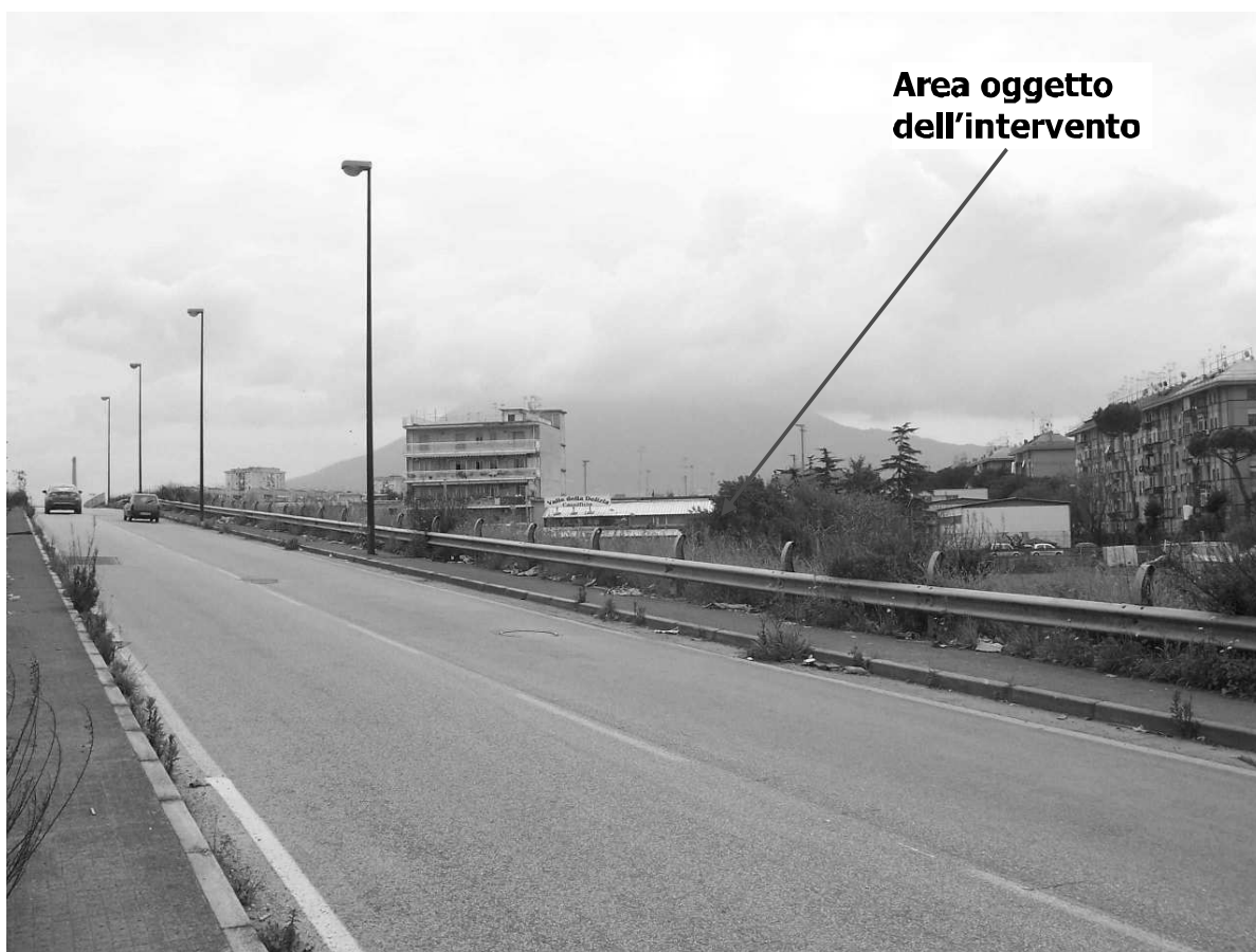
Foto n. 7 – Via Mario Palermo: corsia in direzione Volla
