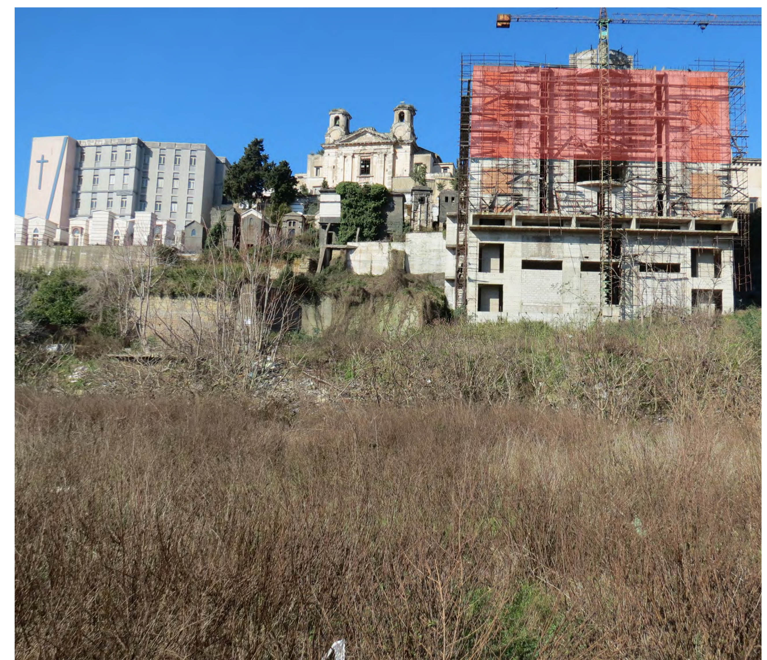
Foto 2_Vista frontale dal basso con indicazione della porzione da demolire
