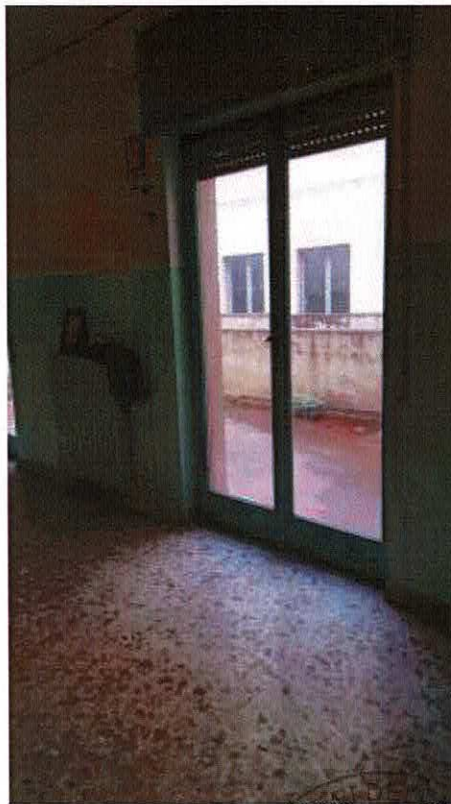
foto 9 (aula piano primo uscita su balcone)
