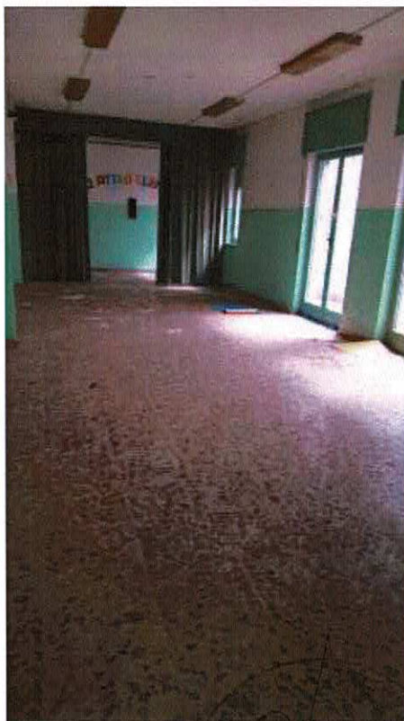
foto 19 (aula piano primo)
