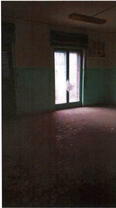
foto 15 (aula piano primo)
