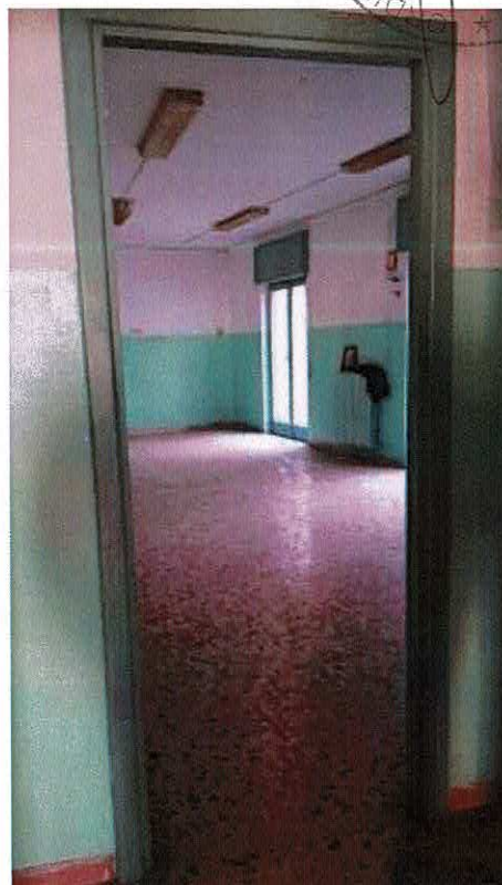
foto 8 (aula piano primo)
