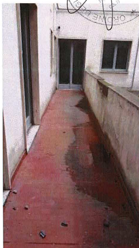
Foto 20 (balcone interno piano primo)
