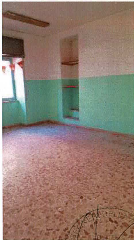
foto 7 (aula piano primo)
