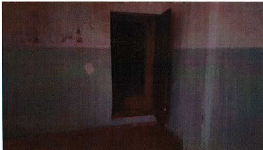
foto 4 (ex locale caldaia)
