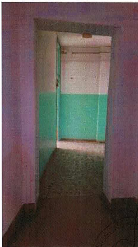
foto 5 (ingresso piano primo)
