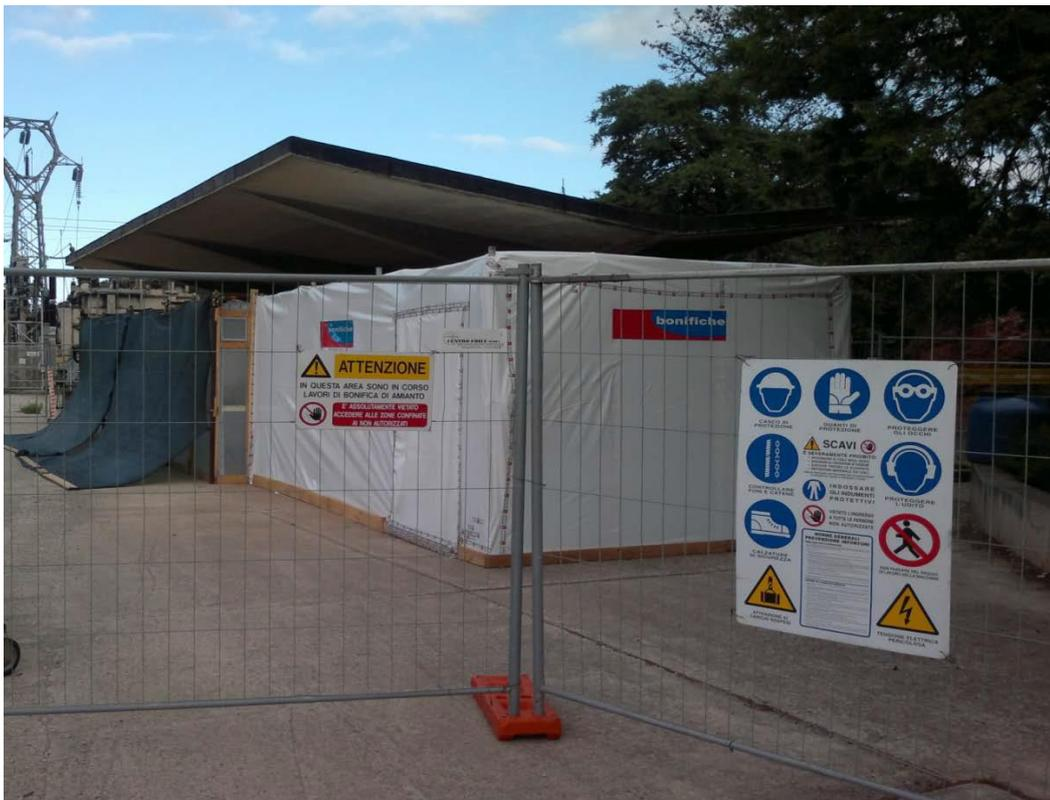
**Figura 3: Esempio di area confinata cantiere rimozione amianto**
