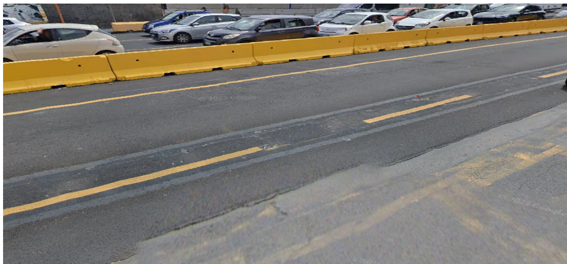
Sede Tranviaria di Via Acton con rotaie coperte e new jersey da rimuovere e sostituire con cordoli
