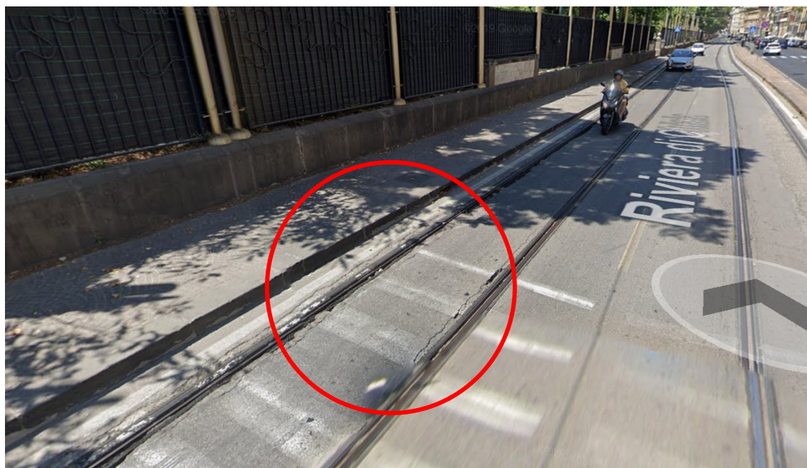
Sede Tranviaria Riviera di Chiaia in cui si evincono disseti all'armamento lungo le gole rotaie
