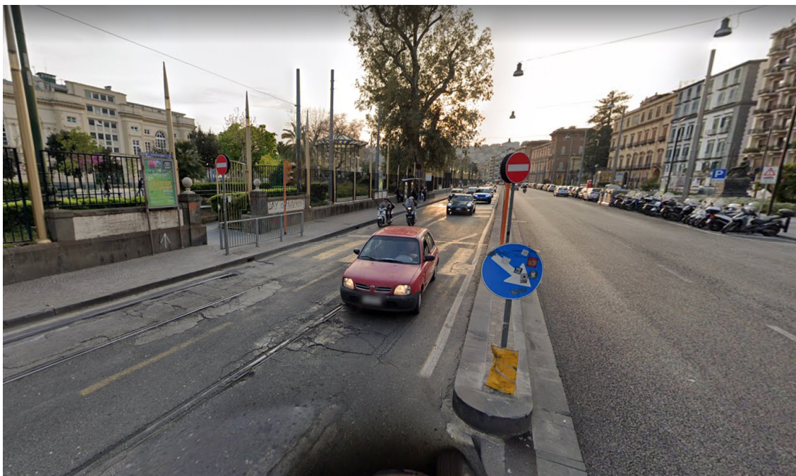
Riviera di Chiaia – P.zza San Pasquale: si evincono dissesti all'armamento lungo le gole rotaie, nell'interbinario e la assenza del tratto di sede tranviaria verso P.zza Sannazaro
