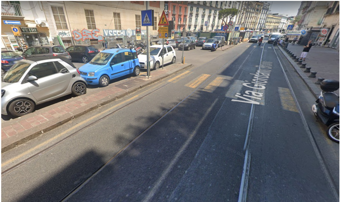
Via Giordano Bruno: si evince la colmataura delle gole rotaia con conglomerato bituminoso
