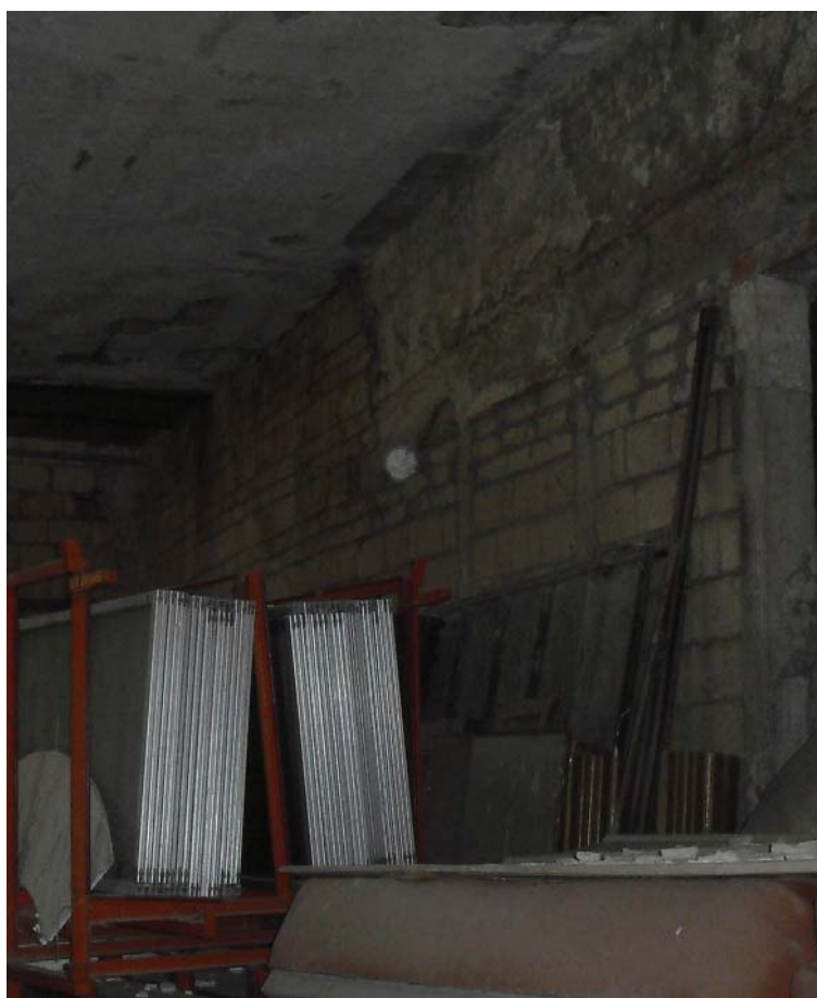
Fig. 7 - Pad.8 - Parete lato pad. 7
