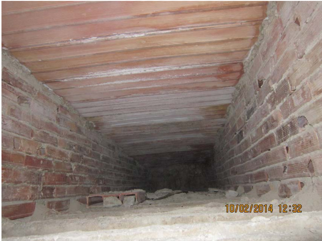
Fig. 5 - Struttura camera d'aria solaio esistente
