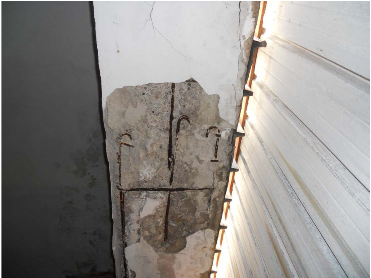
PAD 7 – PIL INGRESSO SX - ARMATURA
