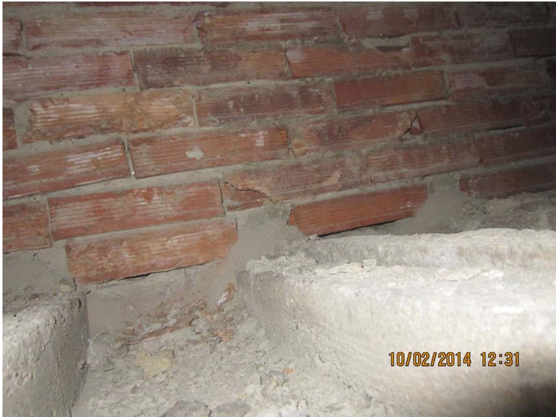
Fig. 4- Estradosso solaio esistente
