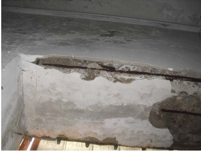
Fig. 10 - Degrado travi
