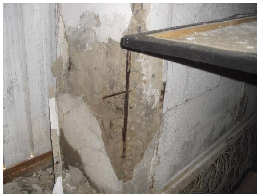
Fig. 9 - Degrado pilastri
