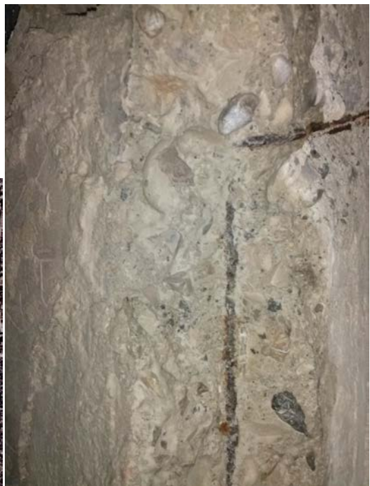
PAD 8 – CAROTA 3 – SCALPELLATURA PILASTRO
