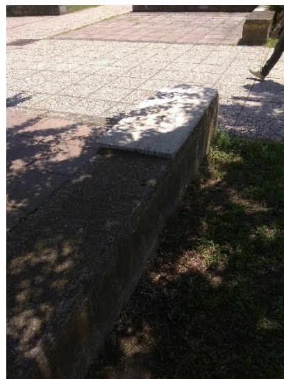
Manifestazioni di degrado puntuale degli elementi di arredo in calcestruzzo, dei beverini e dei muretti
