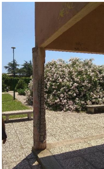
Manifestazioni di degrado puntuale del laghetto e degli elementi in calcestruzzo
