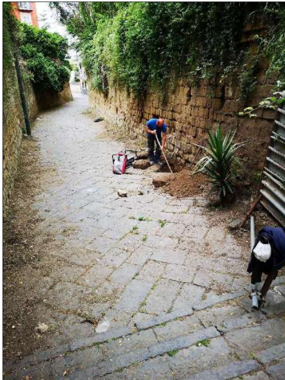
Foto 1: Scavo n° 1 realizzato in prossimità del muro crollato.
