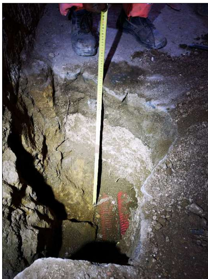
Foto 4: Particolare dello scavo- vista verso monte.
