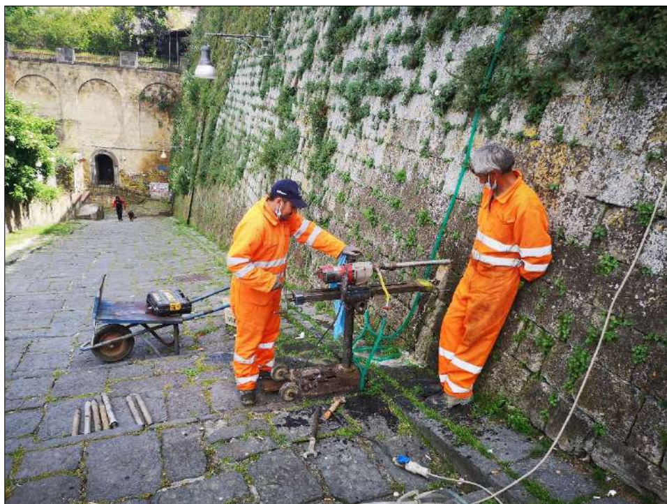
Foto 7: Micro carotaggio n° 2 nella parte alta della prima rampa della scala.
