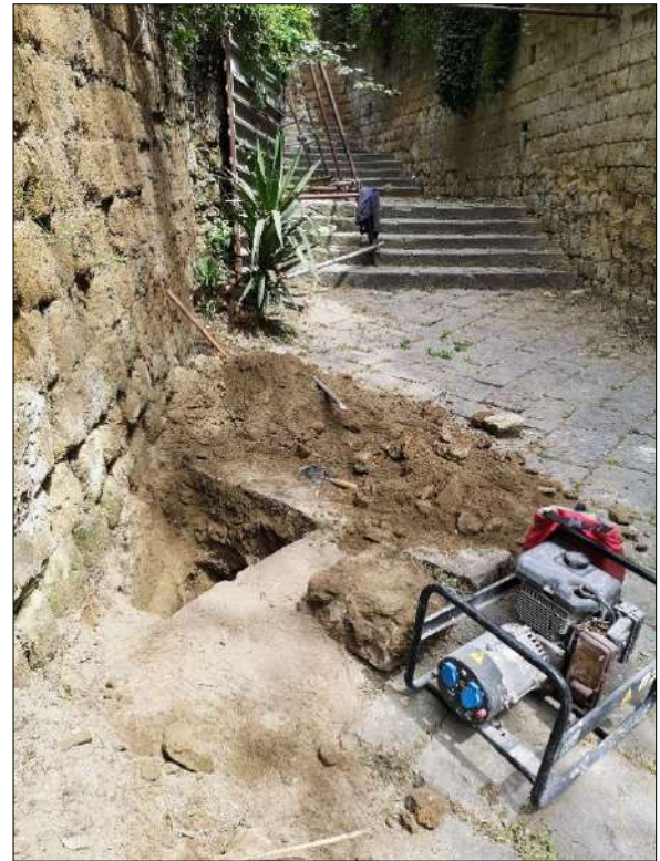
Foto 2: Scavo n° 1 realizzato in prossimità del muro crollato.
