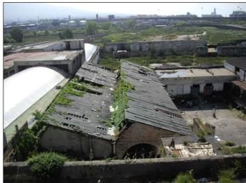
Foto 3 copertura capannoni prima della rimozione del tetto
