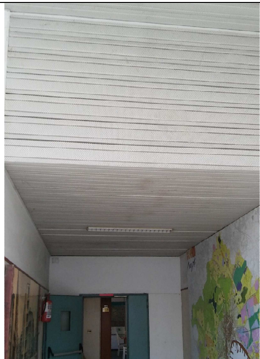
Dettaglio della controsoffittatura
