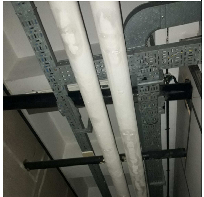
Dettaglio dell'intradosso del solaio dell'interrato
