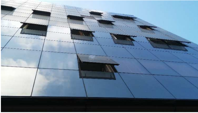
Facciata continua dell'edificio
