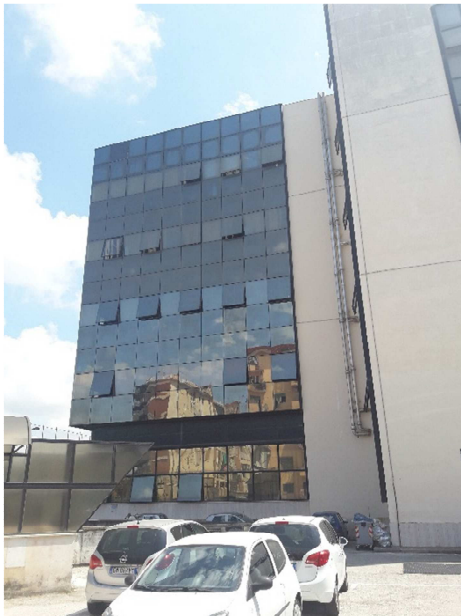
Immagine facciata Sud Ovest
