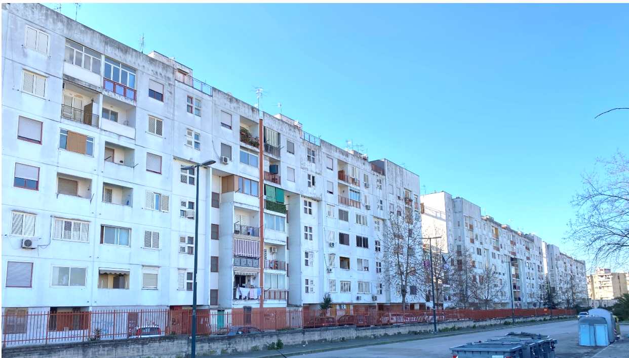
Figura 5.24 – Facciata dell'edificio P4a lungo via Edoardo Scarpetta
