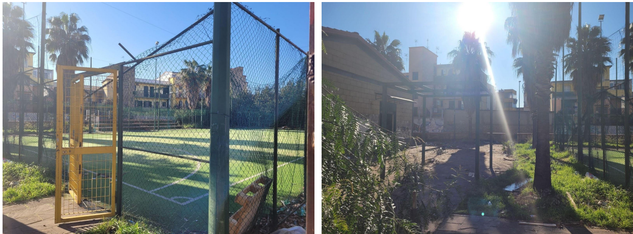
Figura 5.2 - Area adibita ad attrezzature sportive in stato di abbandono
