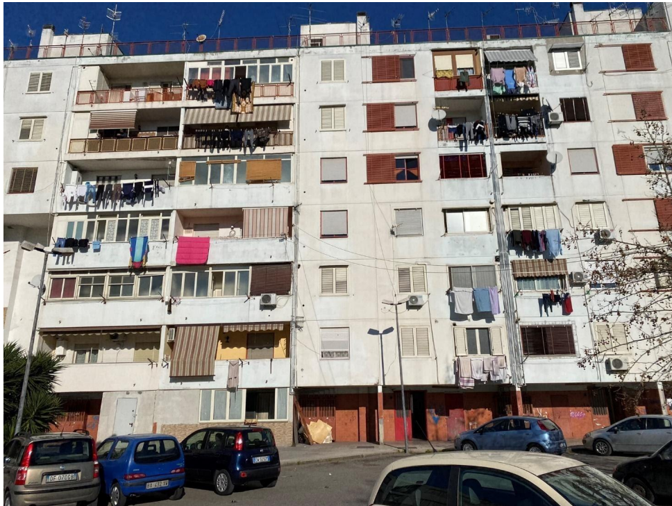
Figura 5.23 – Facciata dell'edificio P4a
