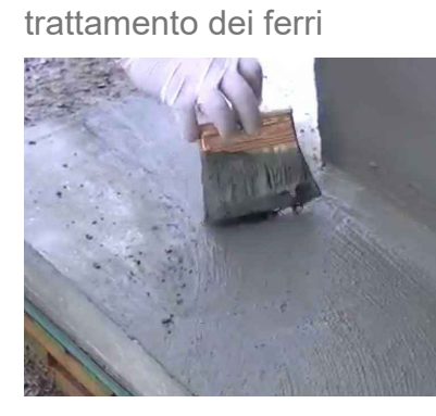
impermeabilizzazione e trattamento finale delle superfici
