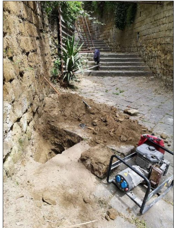
Figura 14 - scavo n° 1 realizzato in prossimità del muro crollato
