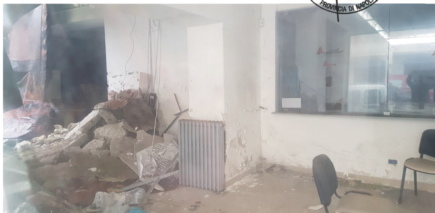
FOTO 3 (part. 69) - SOLAIO COLLATO
