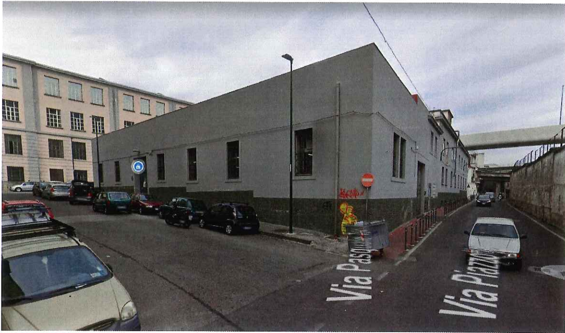
Foto 5: Il Capannone d'impianto a maglia semplice su via P. Turiello
