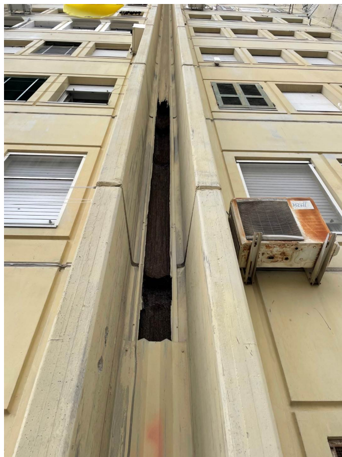
Fotografia 3 Giunto sismico tra blocco A-B e blocco -D
