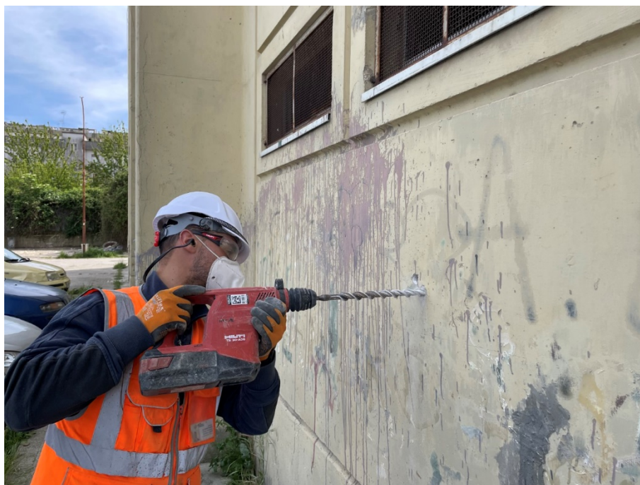
Fotografia 8 Esecuzione di una perforazione stratigrafica
