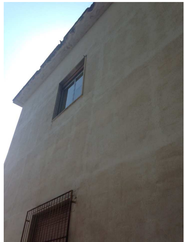
Dettaglio parete esterna intonacata
