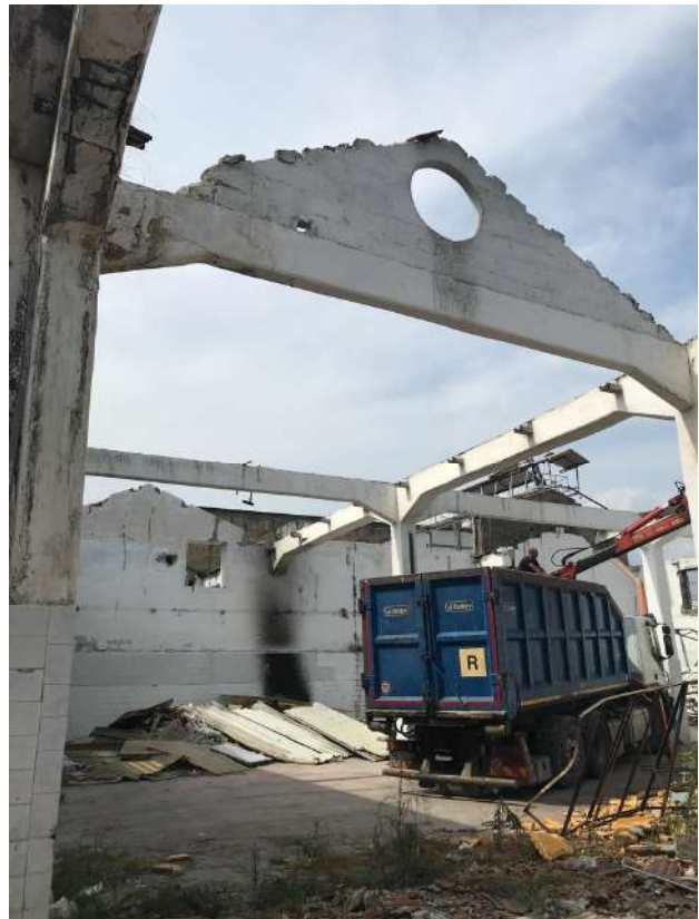
Foto relative alle operazioni di messa in sicurezza e di smontaggio delle coperture esistenti.
