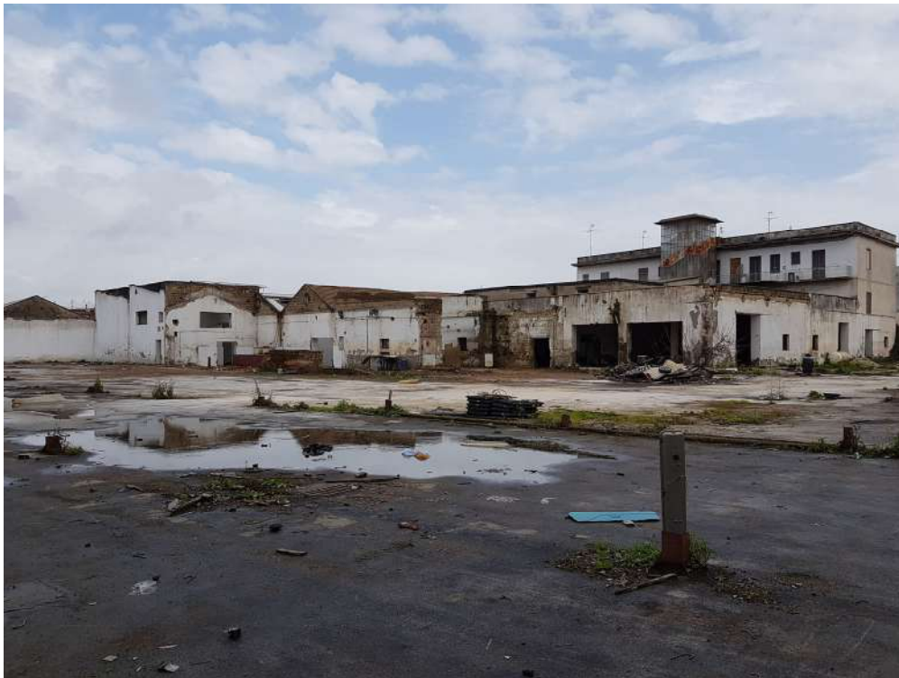
Foto del complesso industriale oggetto dell'intervento
