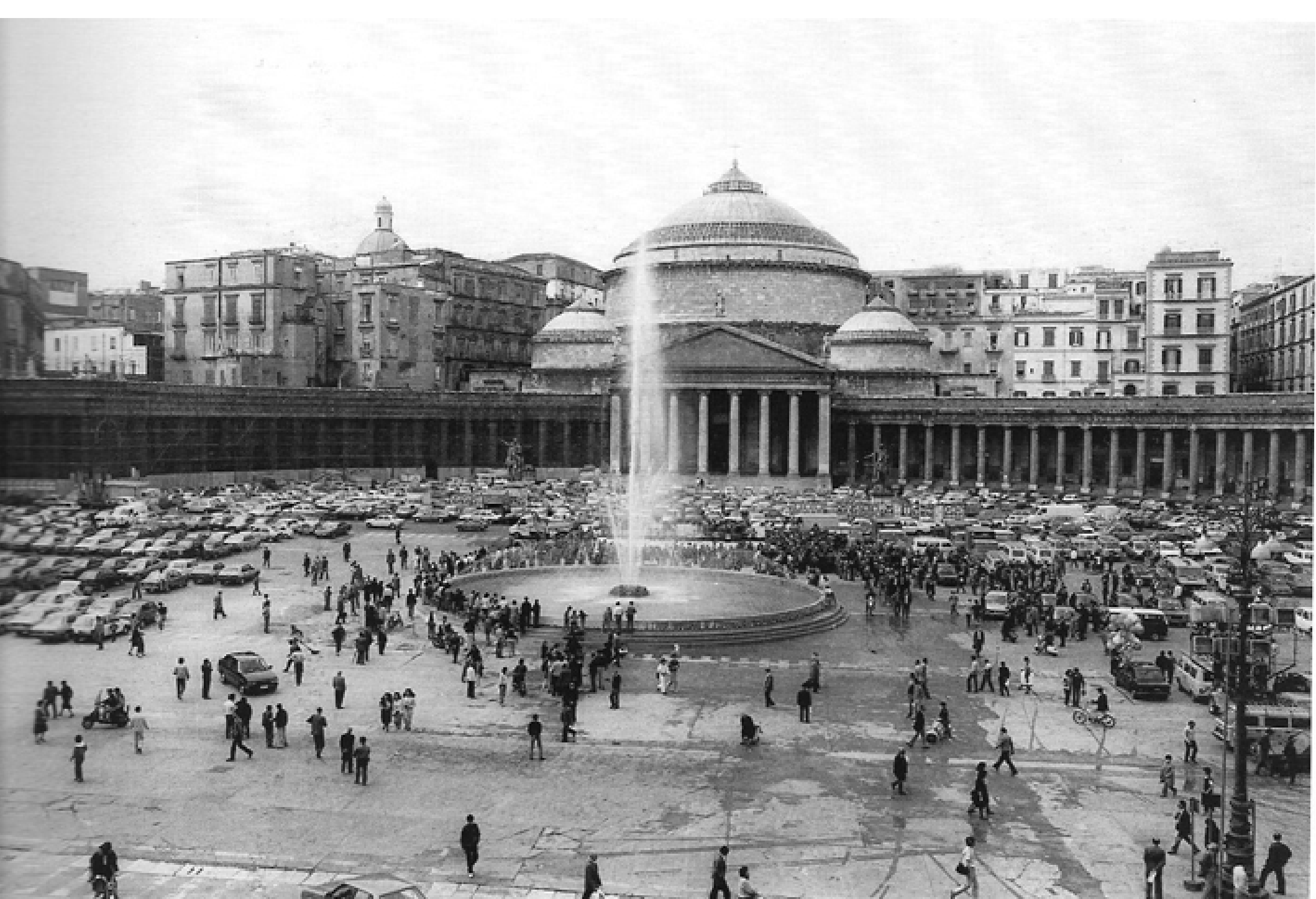
Copia della precedente fontana realizzata nel 1986 per il centenario dell'acquedotto del Serino
