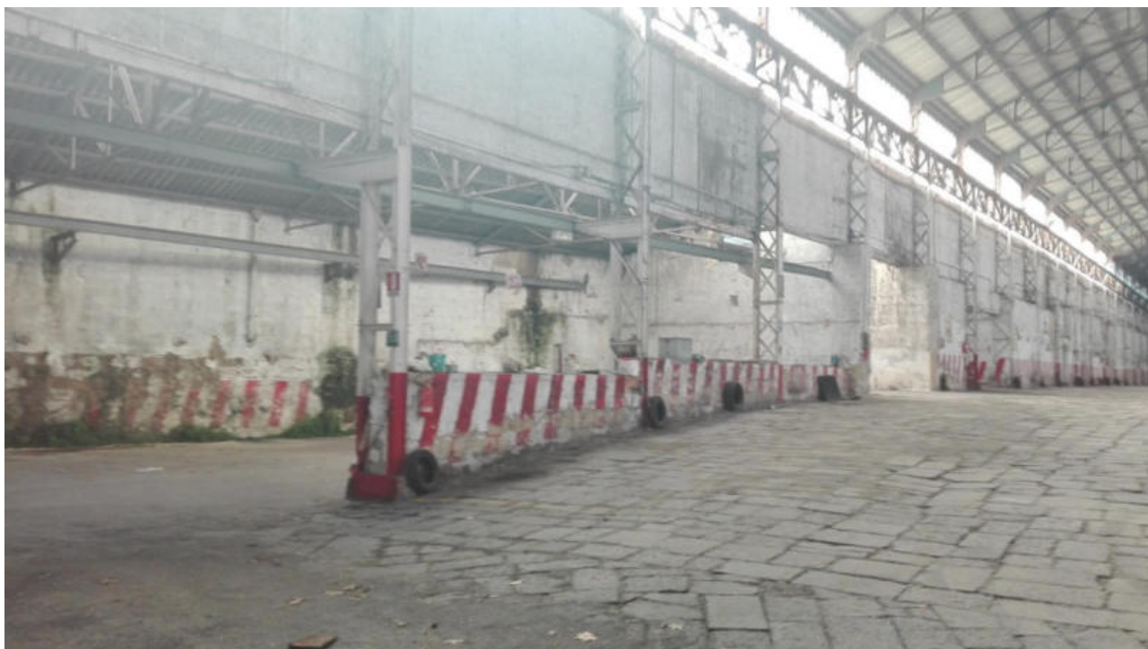
Foto n. 9. Vista interna del locale
