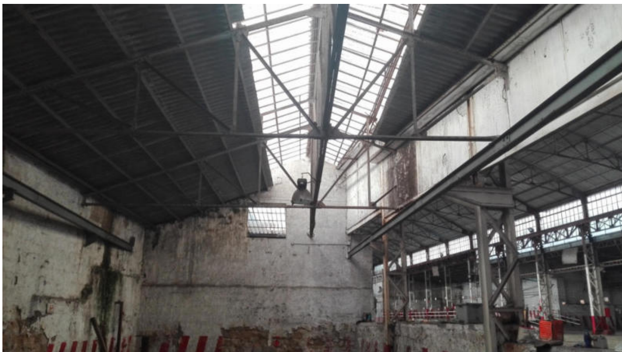
Foto n. 13. Vista interna del locale
