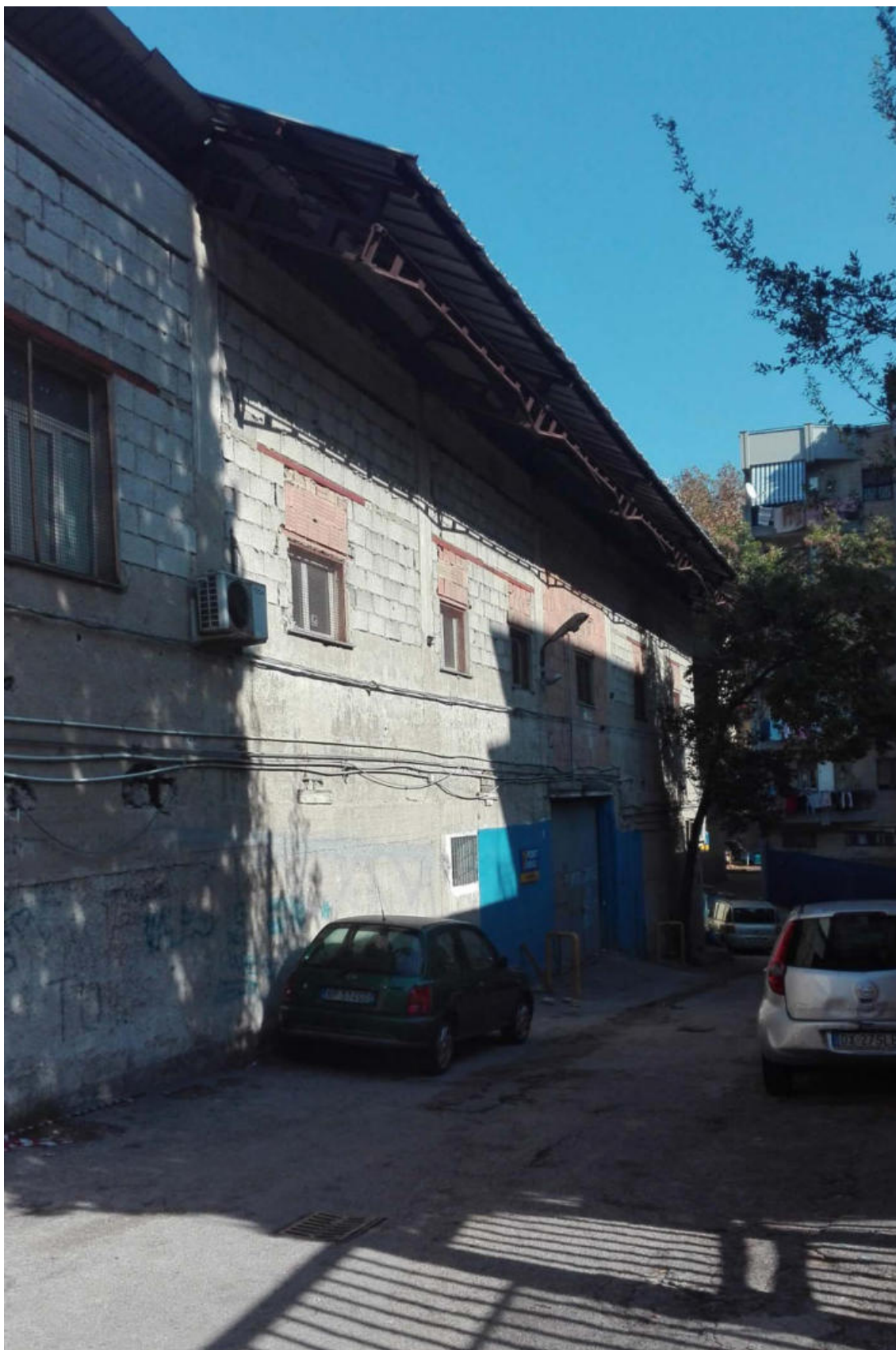
Foto n. 27. Strada privata via Nicolini n. 45 controcampo. Il vecchio capannone tagliato per l'apertura della strada. Si distinguono le unità al piano terra int. D ed al primo piano int. C
