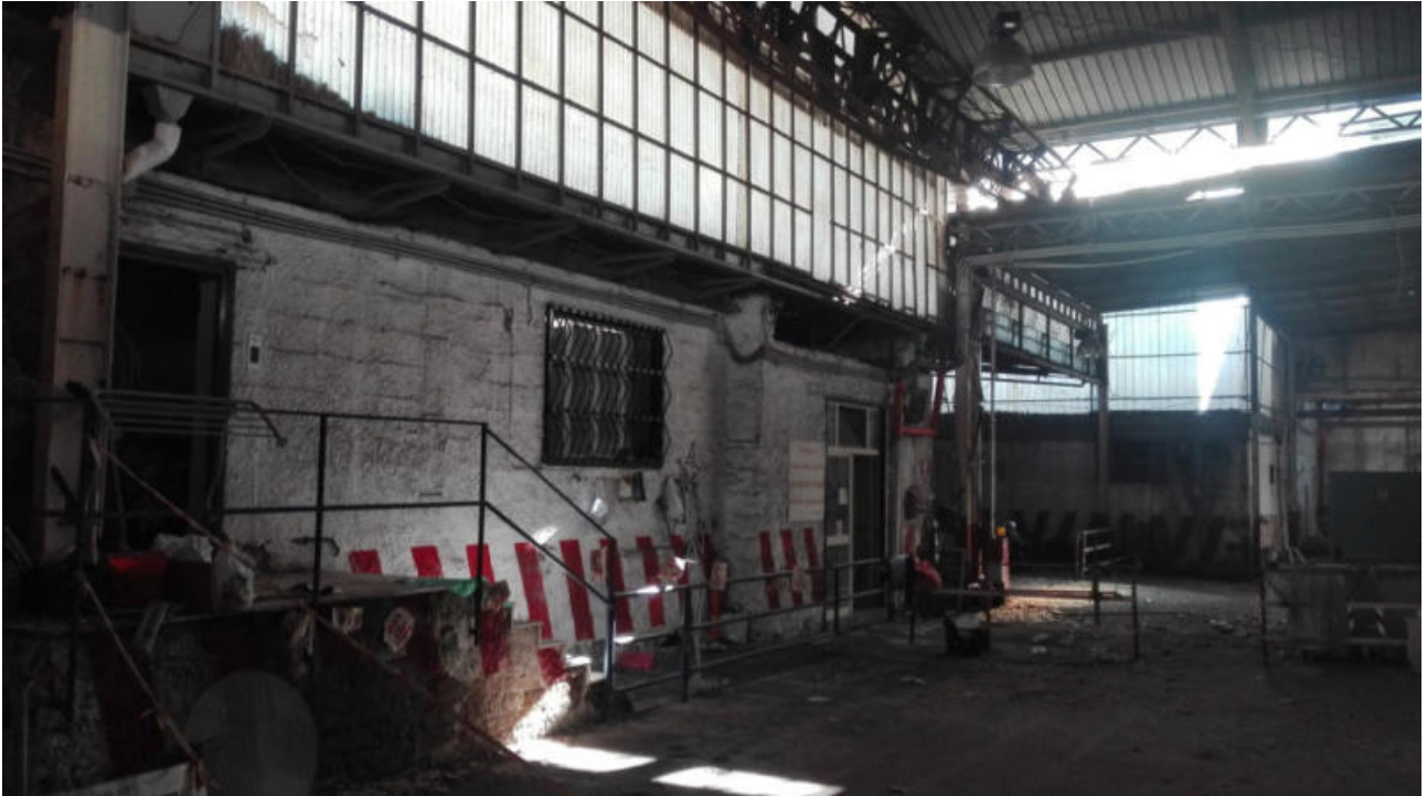
Foto n. 15. Vista della zona di ingresso al capannone di via Nicolini n. 47. Si distingue in primo piano a sinistra il vecchio corpo di fabbrica in muratura di tufo ad unico livello posto sul fronte strada di via Nicolini ed in fondo l'area di ingresso al capannone prima scoperta e poi coperta con lamiera.
