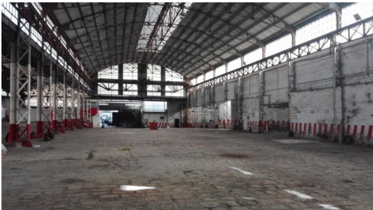
Foto n. 19. Vista interna del locale
