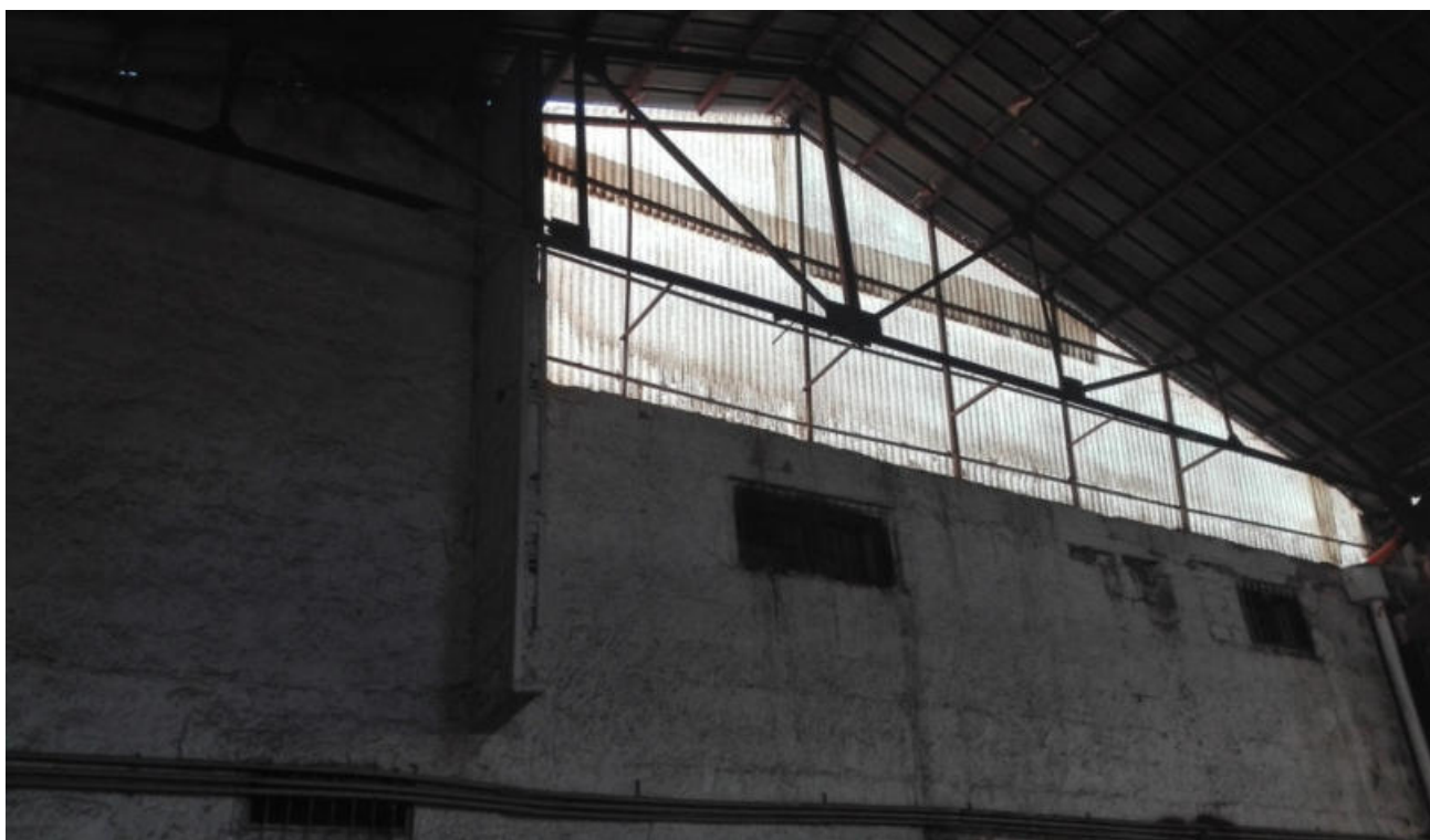
Foto n. 33. Vista interna del capannone con accesso mediante servitù di passaggio parte di confine con il locale negozio sul frontestrada
