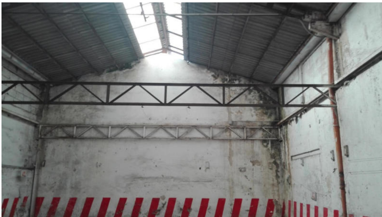
Foto n. 21. Vista interna del locale
