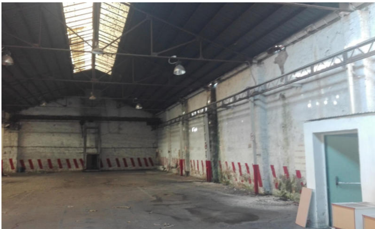
Foto n. 32. Vista interna del capannone con accesso mediante servitù di passaggio
