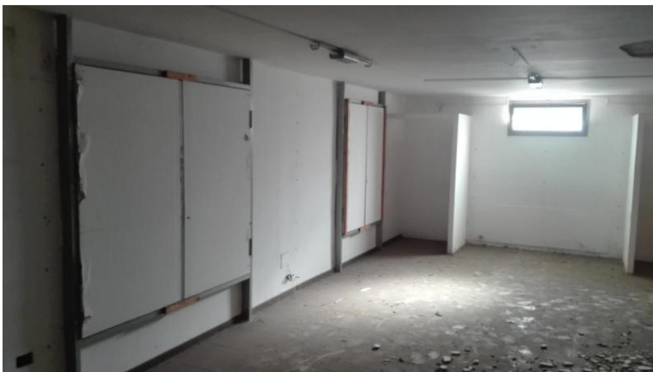
Foto n. 31. Vista immobile via Nicolini 47/A e 47/B piano ammezzato - Locale commerciale
