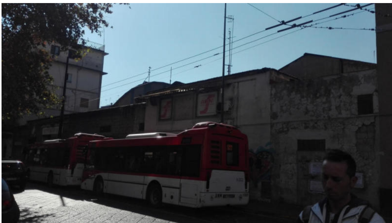
Foto n. 6. Vista dei corpi di fabbrica sul fronte strada via Nicolini. Da destra: il locale cabina enel, il negozio su due livelli, a seguire i due manufatti con accesso dall'interno del civico 47.
