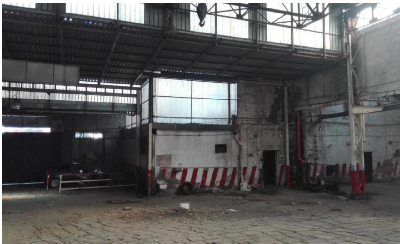
Foto n. 17. Vista della zona di ingresso al capannone di via Nicolini n. 47 si distingue l'area di accesso da via Nicolini.
