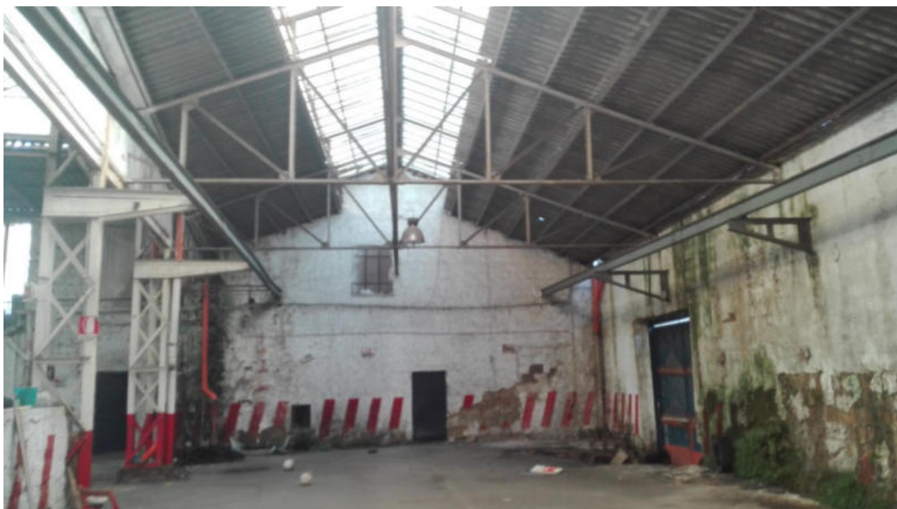
Foto n. 14. Vista interna del locale
