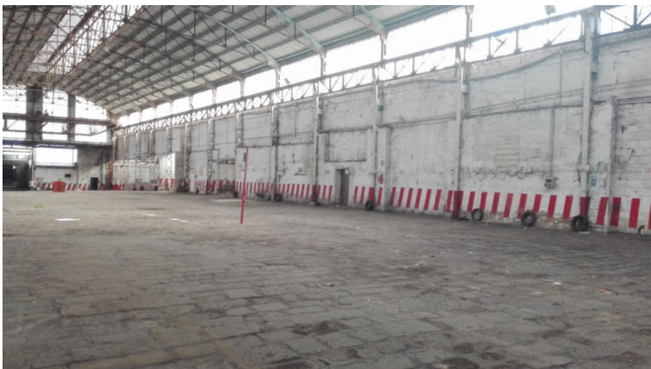
Foto n. 20. Vista interna del locale
