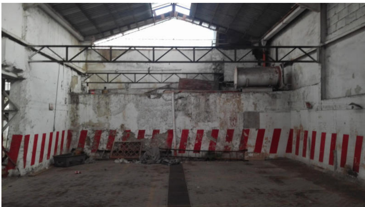
Foto n. 22. Vista interna del locale
