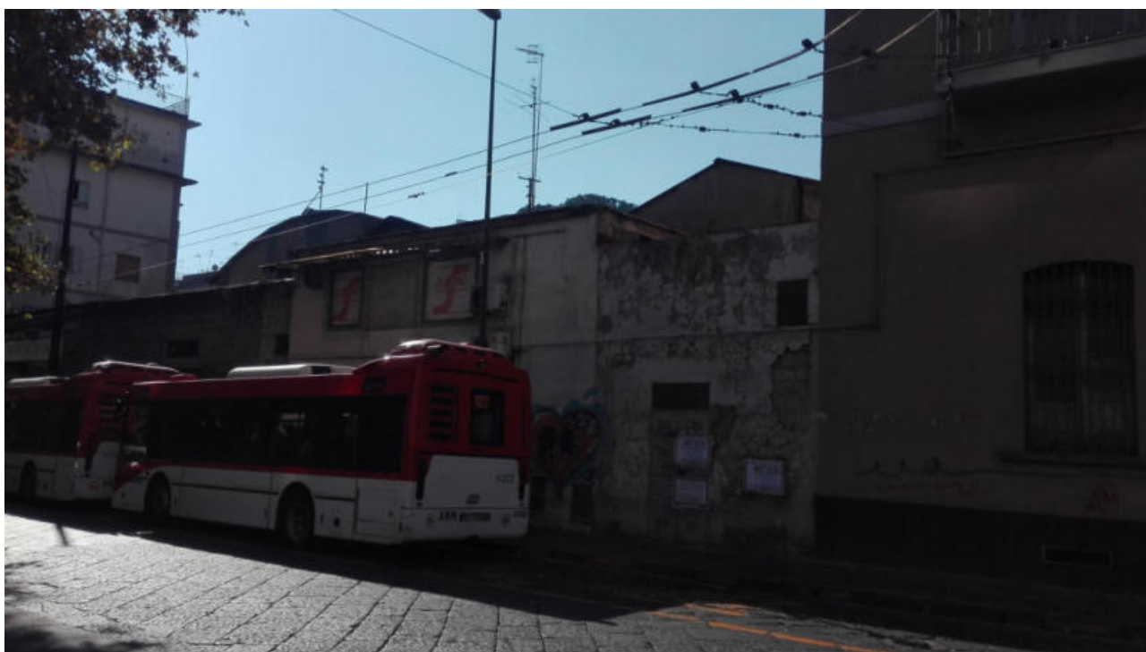
Foto n. 5. Vista dei vari corpi di fabbrica in muratura affiancati sul fronte strada via Nicolini
