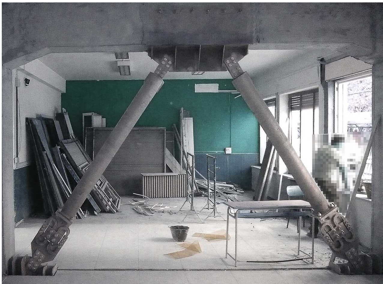
Installazione di controventi dissipativi
