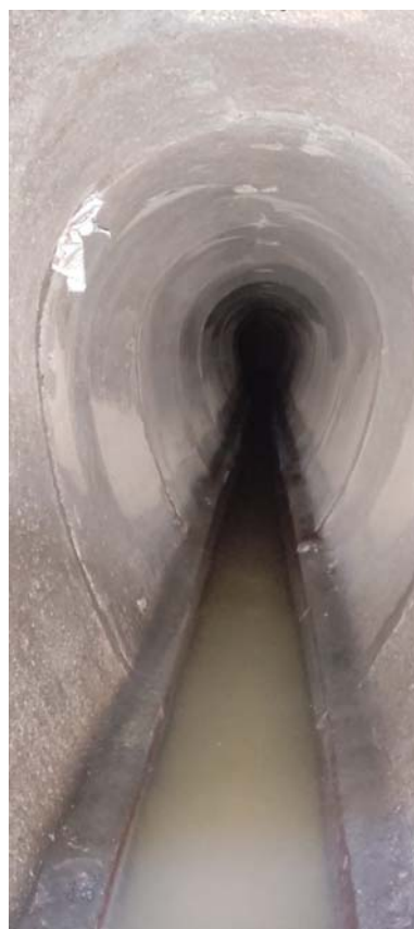
Figura 6 - veduta interna collettore esistente
