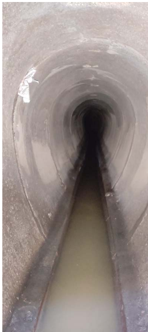
Figura 4 - veduta interna collettore esistente
