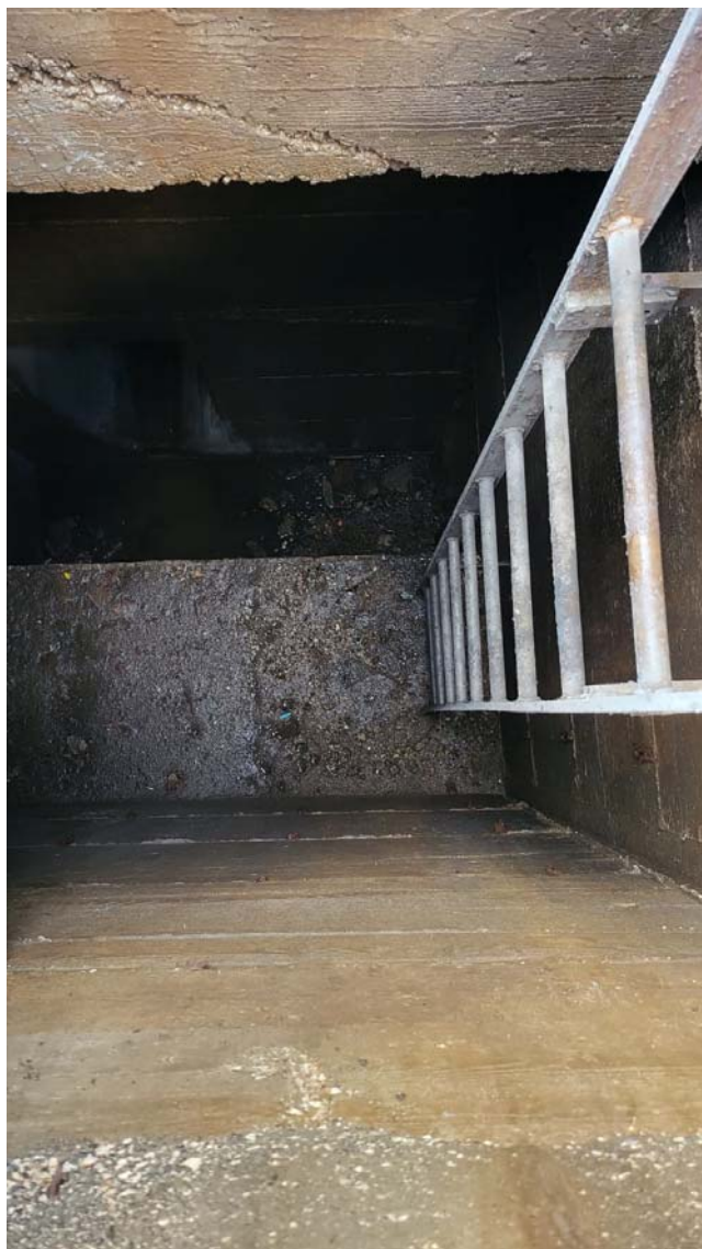
Figura 3 - cameretta di accesso al collettore ovoidale
