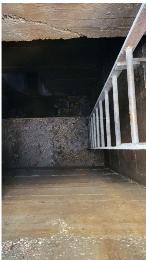
Figura 5 - cameretta di accesso al collettore ovoidale
