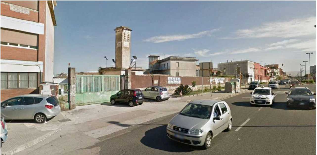
Vista da Via Argine - Stato di fatto
