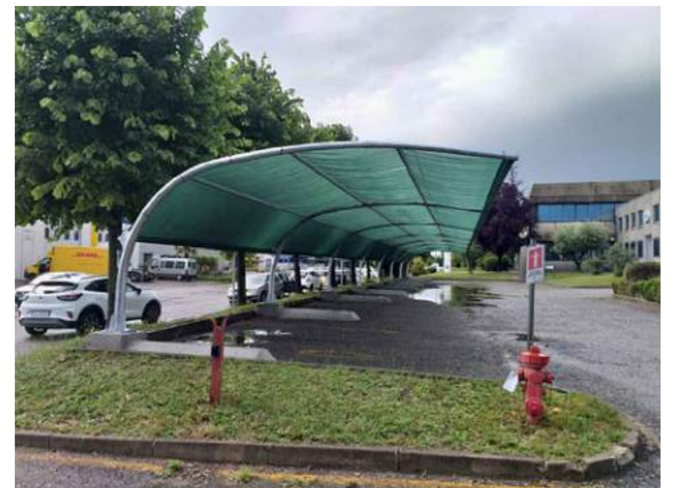
FILARE ALBERATO PARALLELO ALLE PENSILINE OMBREGGIANTI A PROTEZIONE DELL'AREA DESTINATA A PARCHEGGIO
