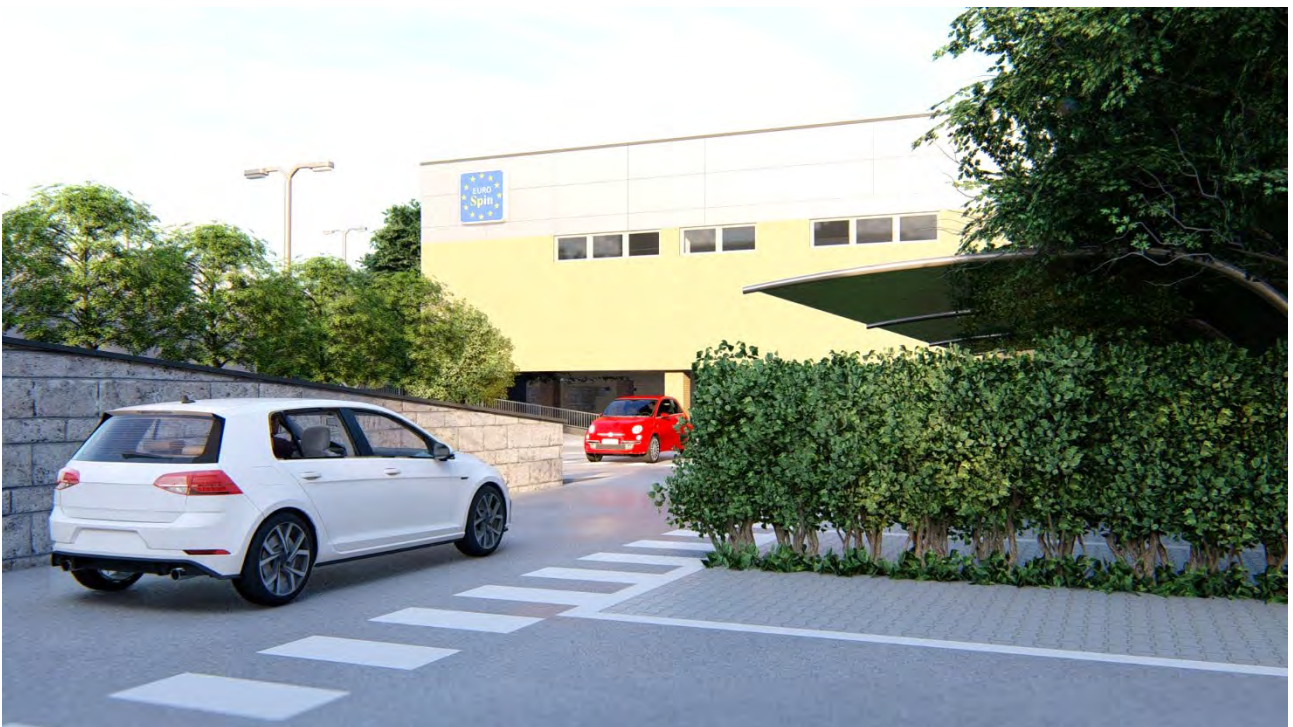
Immagine 16. ingresso alla struttura commerciale lato sud – piano seminterrato
