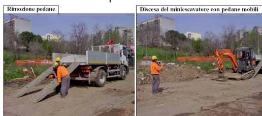
Descrizione Figura: Modalità di discesa dei mezzi d'opera (escavatore, muletto)
