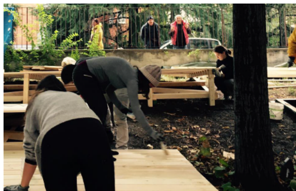
Workshop costruzione area eventi
