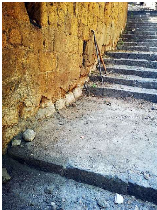
Foto 11: Ripristino dello stato dei luoghi.
