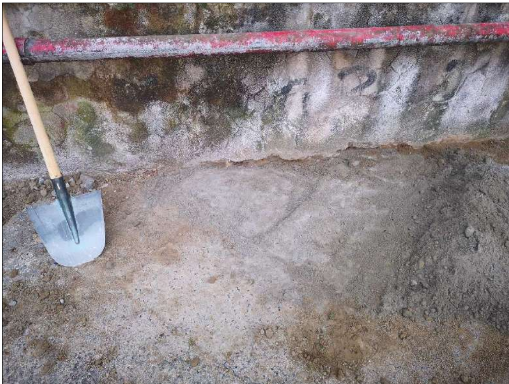
Foto 4: Ripristino dello stato dei luoghi scavo n° 1.
