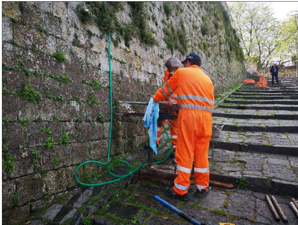
Foto 6: Micro carotaggio n° 2 nella parte alta della prima rampa della scala.
