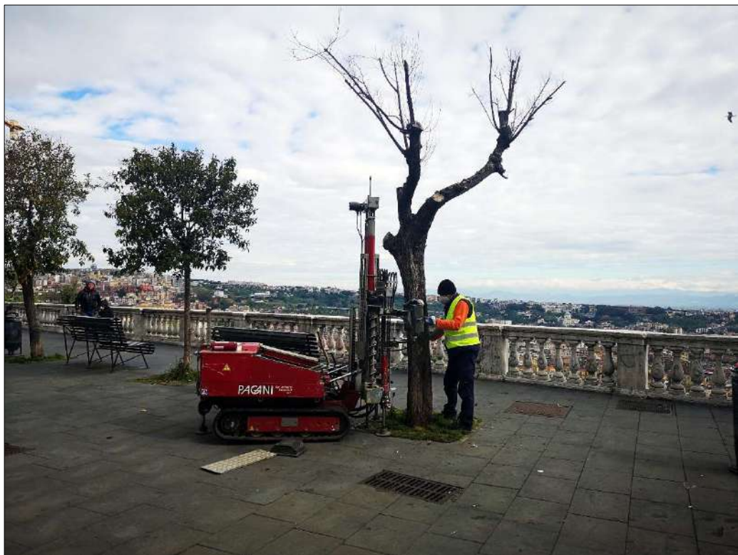
Foto 3: Area in cui è stata realizzata la prova DPSH n° 2.
