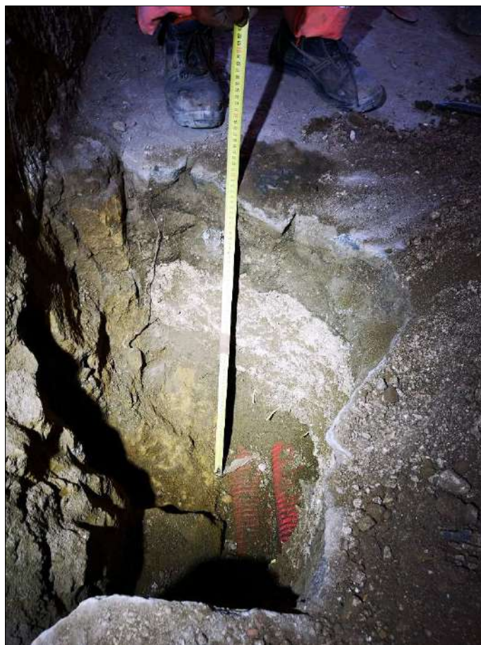
Foto 4: Particolare dello scavo- vista verso monte.
