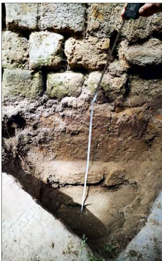
Foto 3: Scavo n° 1 realizzato in prossimità del muro crollato.
