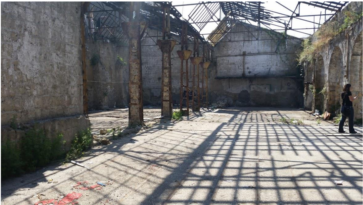
Foto 7 tav.G02A Vista capannone lato destro
