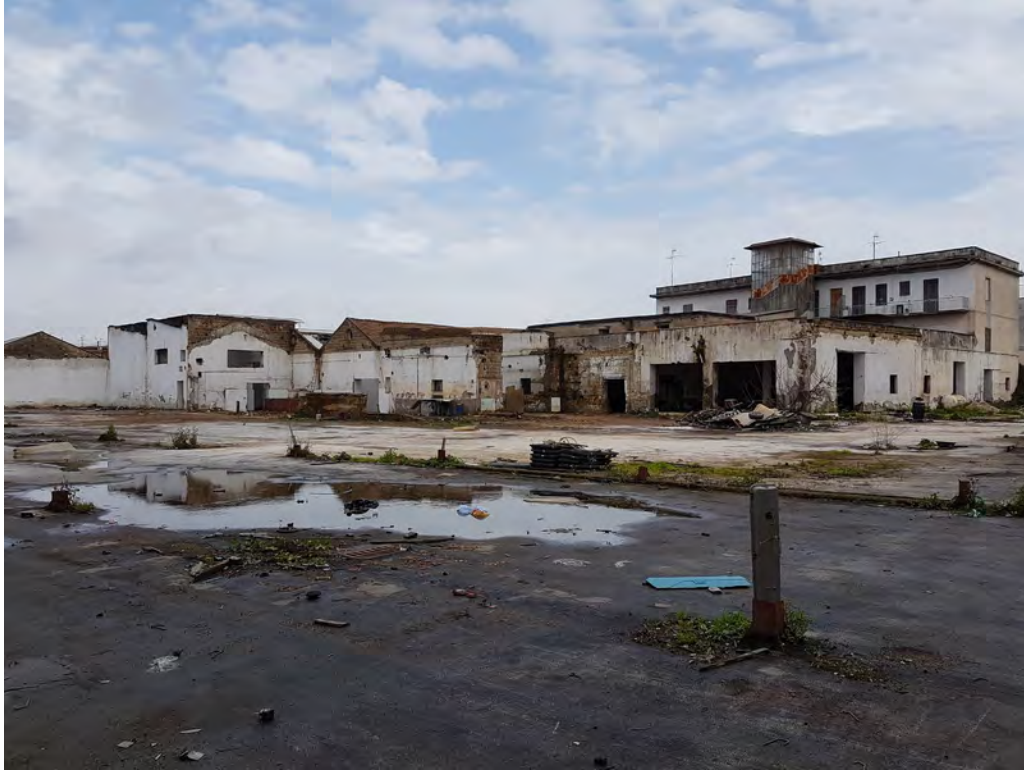
Foto del complesso industriale oggetto dell'intervento
