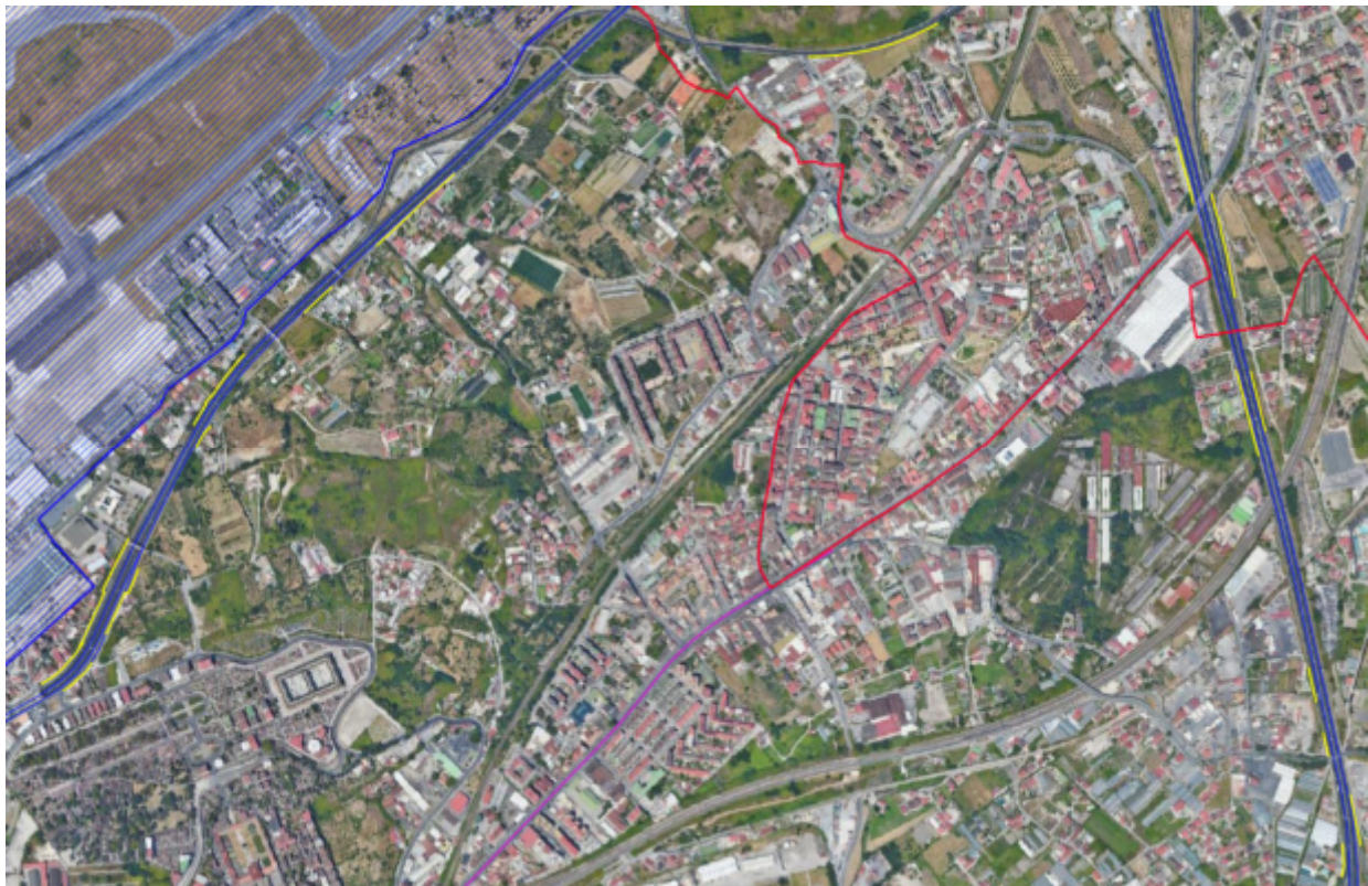
Figura 2 – Localizzazione delle barriere antirumore (Autostrade per l'Italia S.p.A.)
