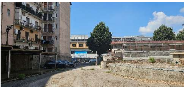
Figura 12: Vista in direzione ovest del piazzale di ingresso all'area: A sx gli stalli parcheggio esistenti. L'albero visibile è esterno alla proprietà.
