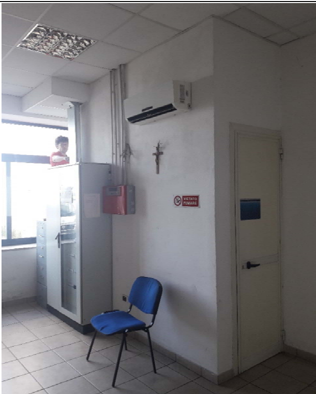
Immagine interna del sopralluogo
