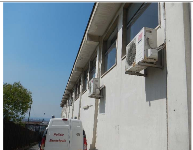
Scorcio di facciata con split
