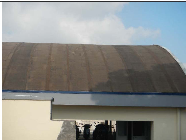
Copertura curva dell'edificio
