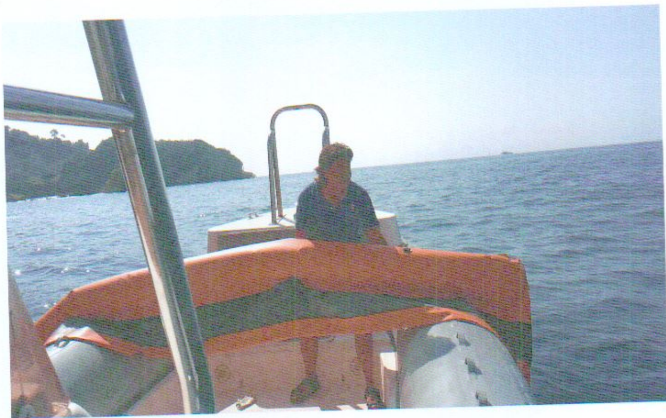
Unità nautica Fort'Ovo - Posizionamento barriera galleggiante in località Cala Badessa - Arena S. Antonio - sezione di sbocco della galleria scolmatrice di Coroglio del sistema fognario misto urbano.
