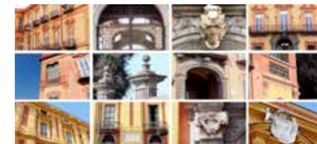
DETTAGLI ARCHITETTONICI IN PIPERNO DALLE VILLE GRANITO DI BELMONTE, SIGNORINI E FAVORITA.
