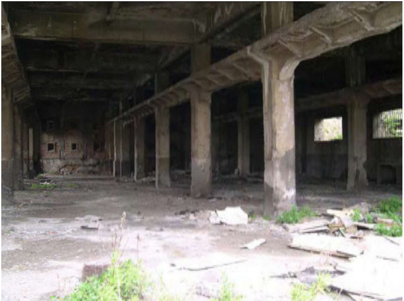
Figura 60 - Edificio 11, Uffici e magazzini spedizioni. Interni.
