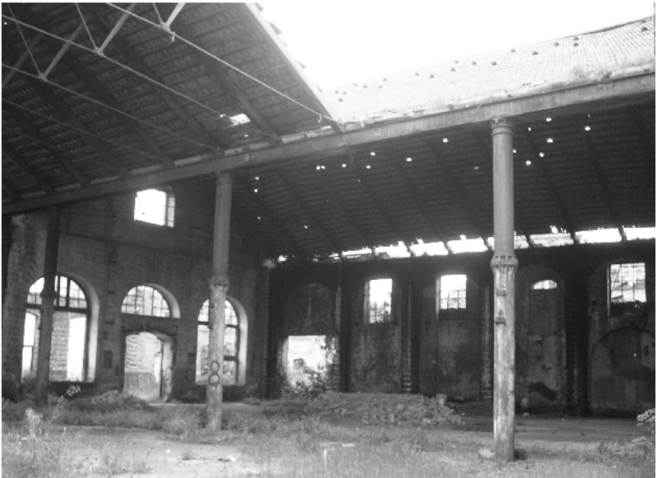
Figura 54 - Edificio 8, Capannone ex-fonderia getti. Fotografia antecedente al crollo delle coperture.
