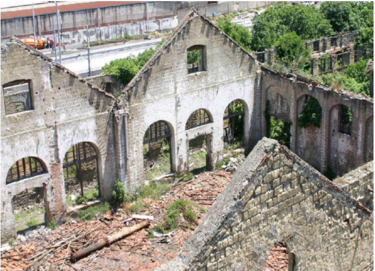
Figura 55 - Edificio 8, Capannone ex-fonderia getti. Fotografia recente.
