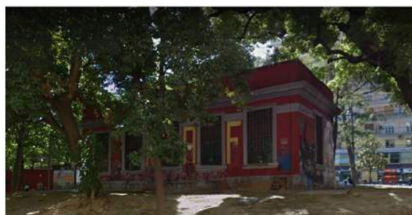
EDIFICIO ESISTENTE DA RIQUALIFICARE
