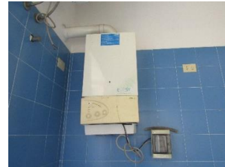
Figura 4.5- Particolare di una caldaia murale per la produzione di acqua calda sanitaria
