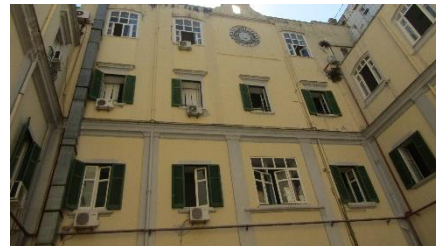
Figura 4.6- Particolare di facciata con macchine all'esterno
