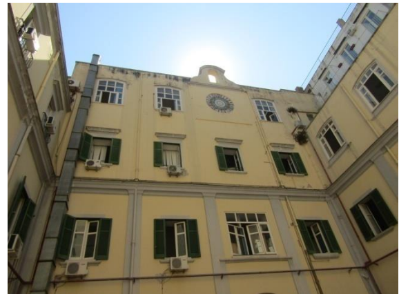
Figura 4.1 - Particolare della porzione di facciata
