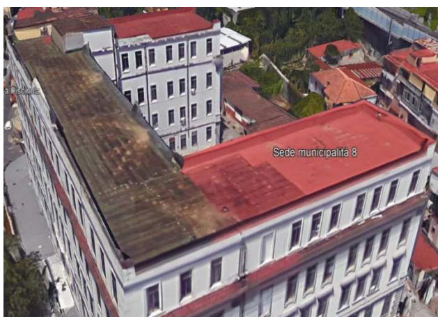
copertura impermeabilizzata con manto bituminoso
