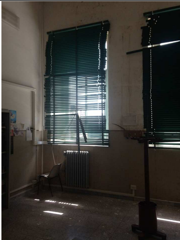
Immagine relativa al degrado dell'intonaco esterno in corrispondenza delle finestre del quarto piano fuori terra
