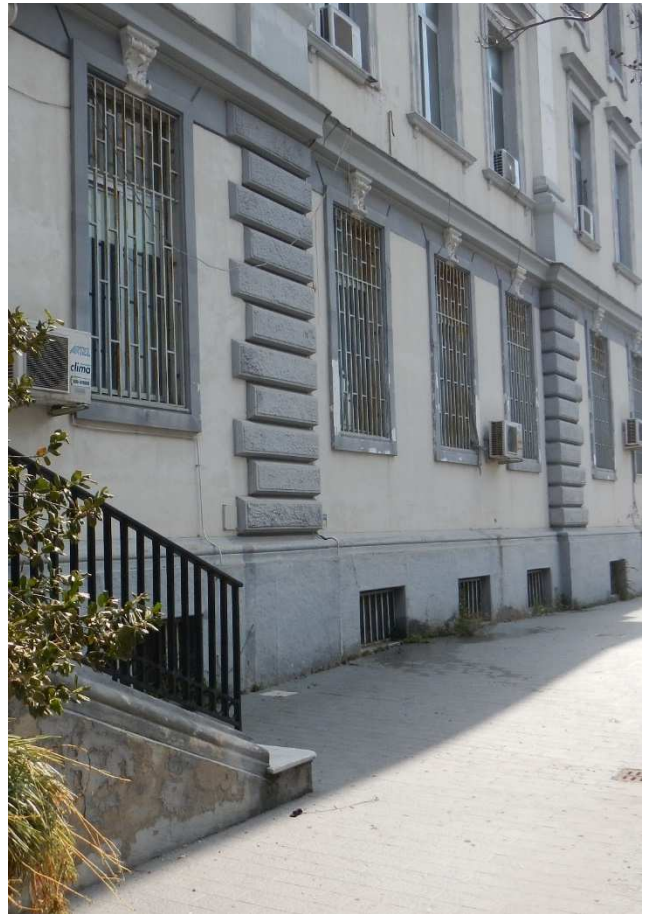
Dettaglio parete esterna intonacata e decorata
