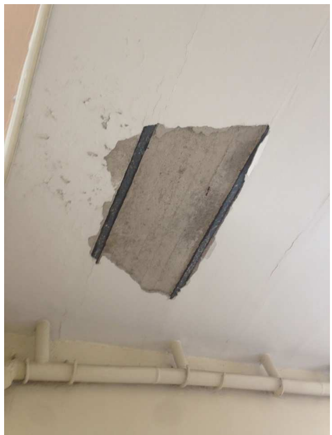
Dettaglio solaio interpiano in acciaio e cemento
