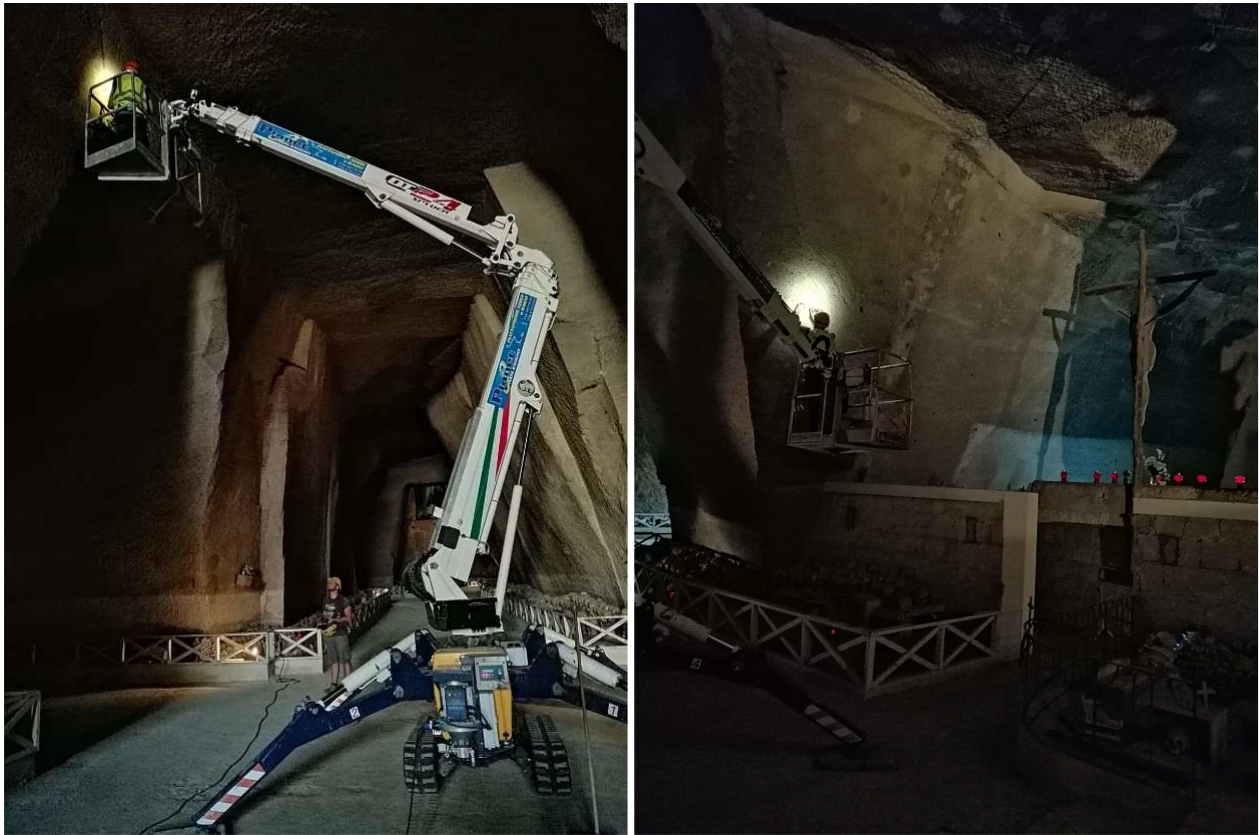
Figura 12. Ispezioni in quota dello stato di conservazione degli interventi eseguiti nel 2000.
