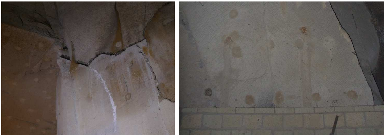
Figura 13. Chiodature dei pilastri e delle pareti eseguiti nell'ambito degli interventi del 2000.
