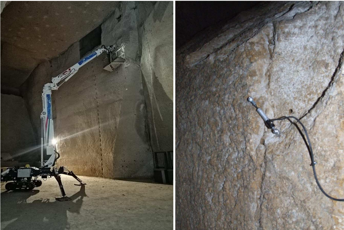
Figura 21. Installazione di estensimetri elettrici in corrispondenza di spigoli.
