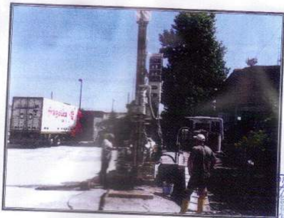
FOTO N. 7 - Sondaggio n. 3 - Prova SPT
