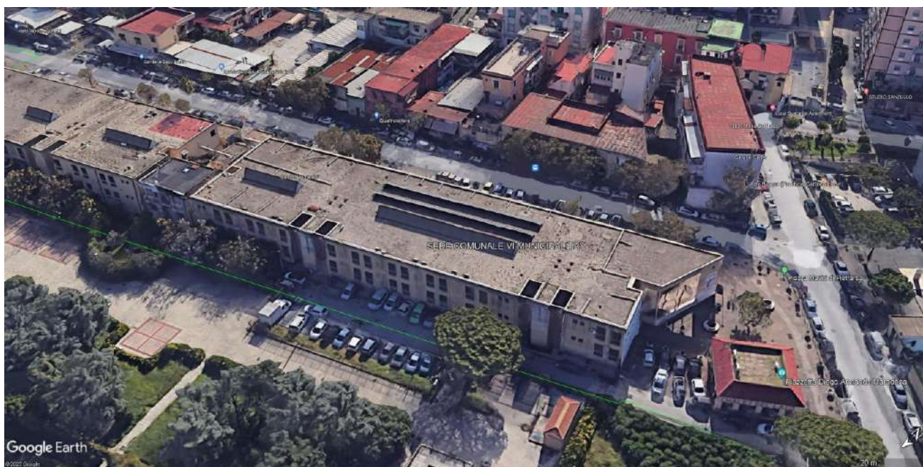
Vista 3D da Google Maps del prospetto della sede comunale prospiciente l'area parcheggio
