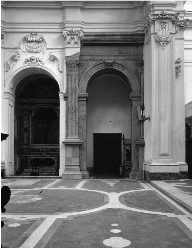
L'arcone dopo l'intervento di restauro
