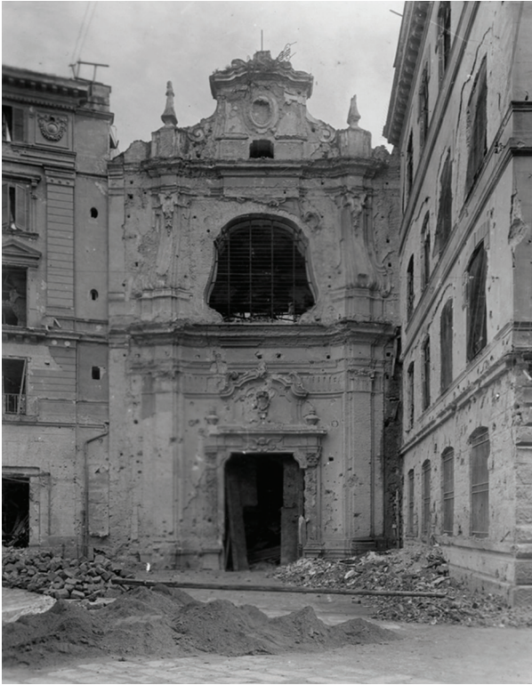
I danni della guerra: la facciata
