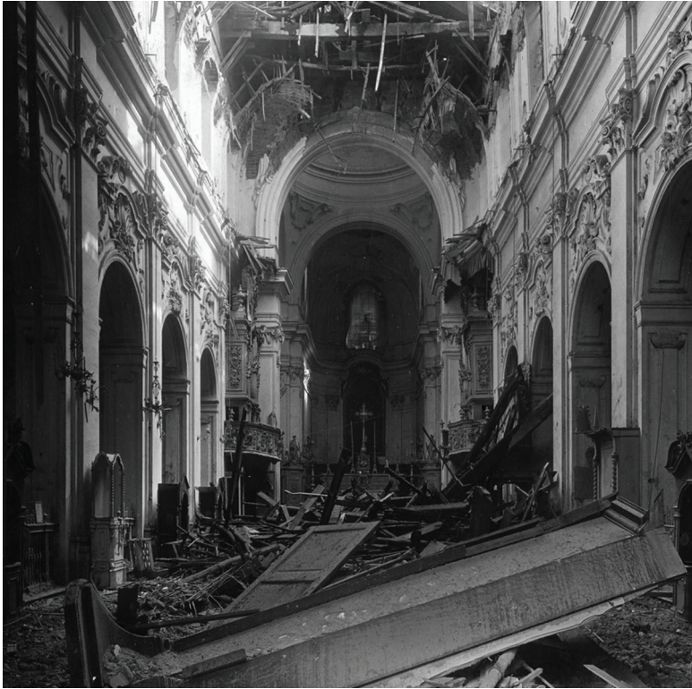
Il crollo del tetto
