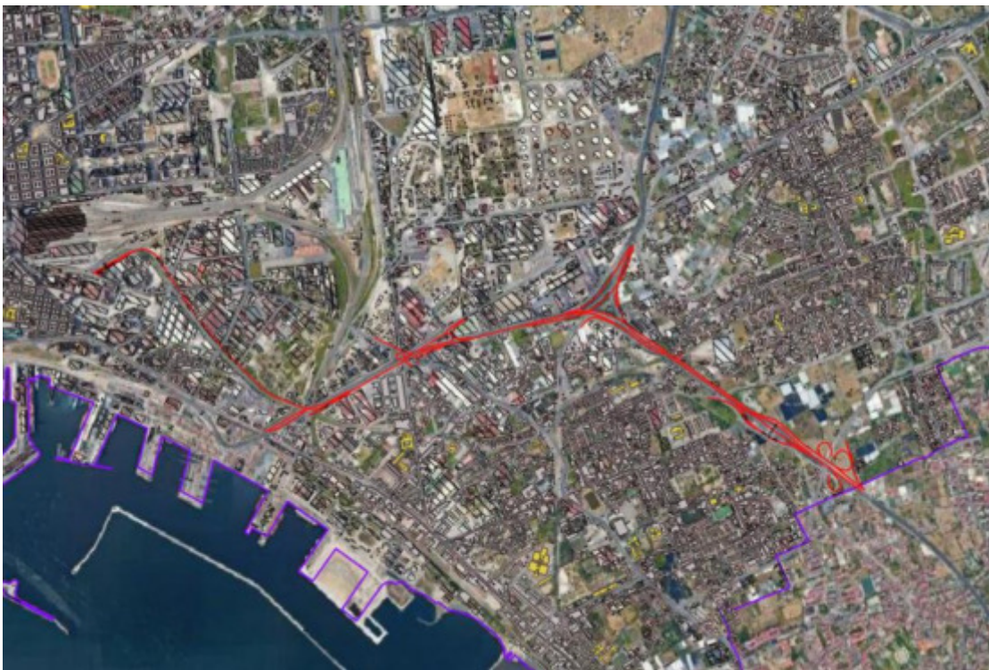
Figura 8 – Infrastrutture di pertinenza di Autostrade Meridionali S.p.A.
