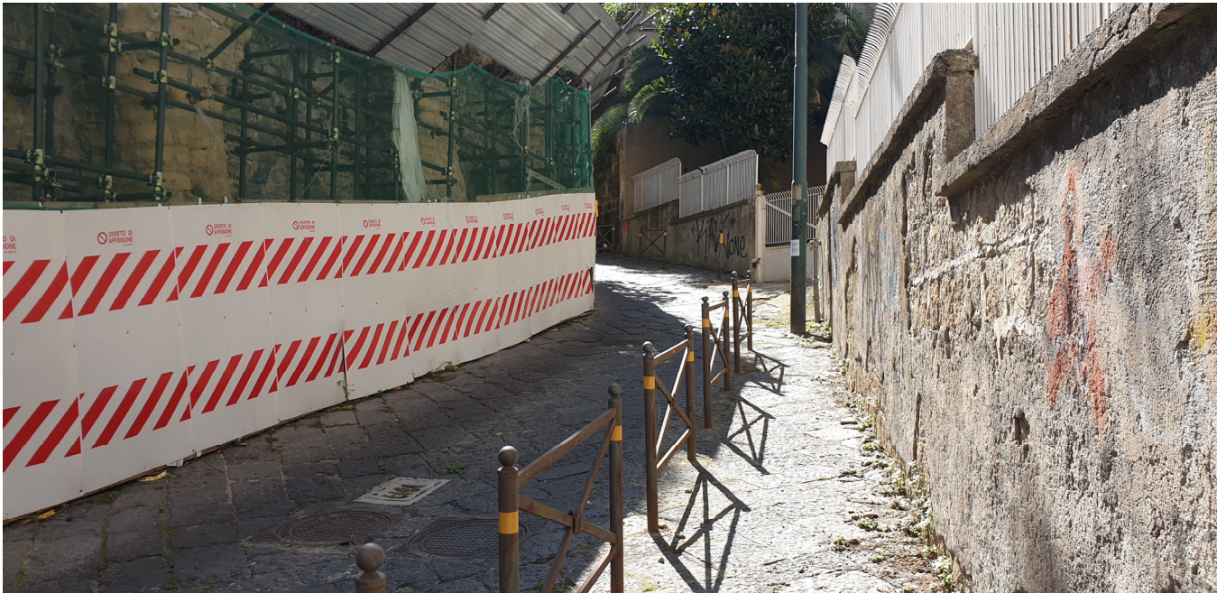
Figura 10_Dissuasore a balaustra in metallo
