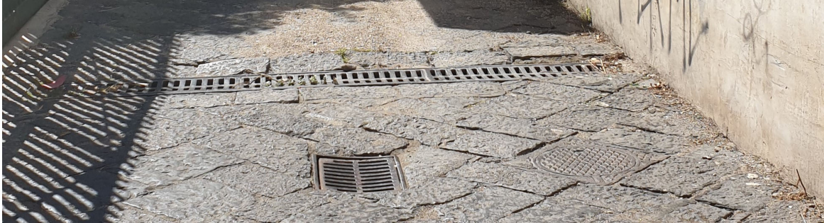
Figura 10_ Caditoia in metallo Q5 – Caditoia in metallo Q4 - Chiusino in metallo K1
