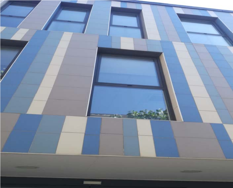
Facciata con rivestimento in piastrelle
