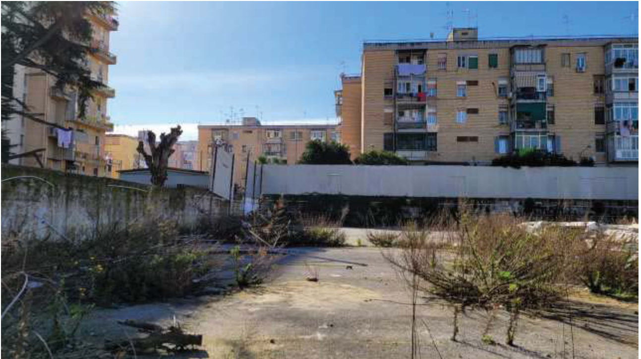
Figura 3: Foto dell'interno dell'area lato sud
