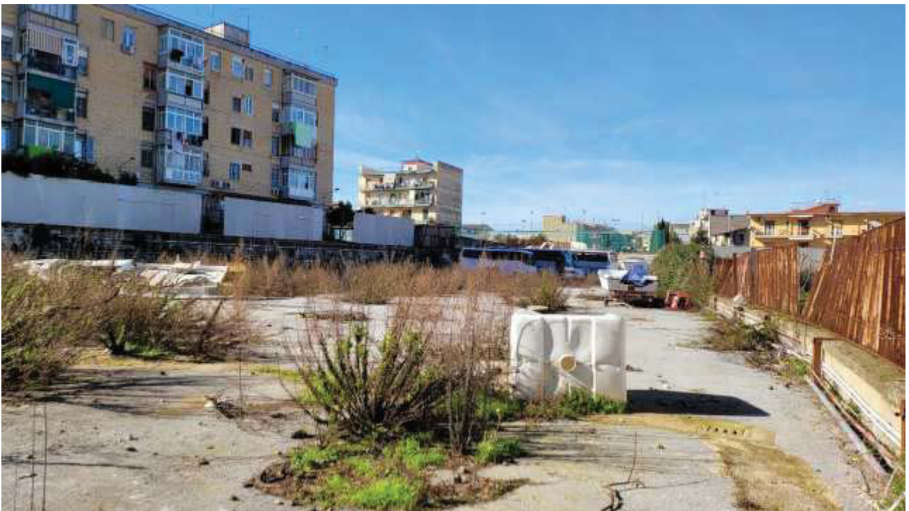
Figura 4: Foto dell'interno dell'area lato est
