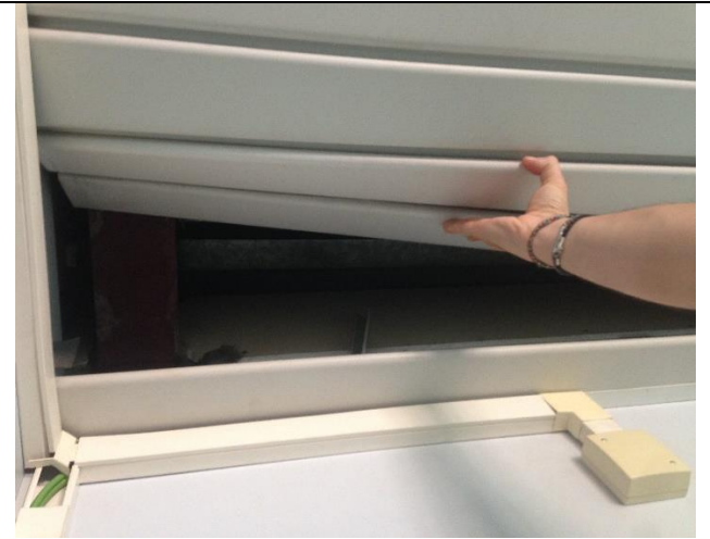
Dettaglio della controsoffittatura
